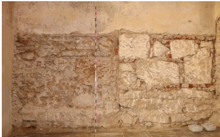
Westwand während Bauforschung
