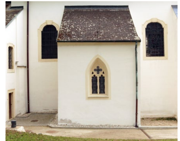
Nordfassade der röm.-kath. Pfarrkirche mit Kapellenanbau
