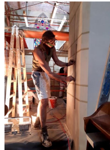
Wiederherstellung der Raumschale
