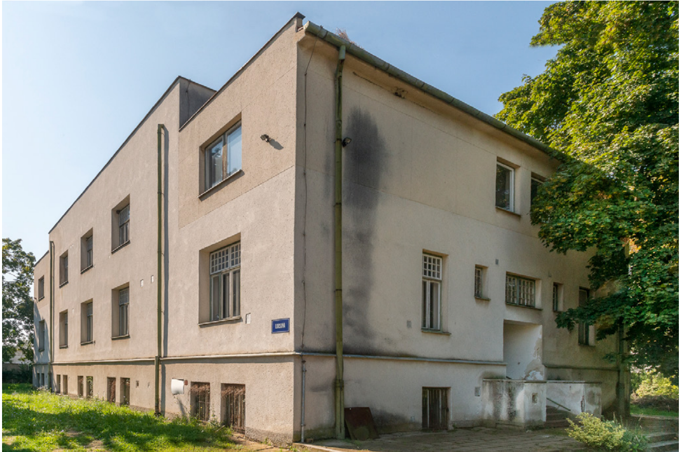
Abb. 9: Ansicht der Villa von Nordost, Aufnahme 2020, Museum der Stadt Brünn
