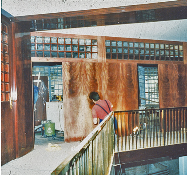
Abb. 19: Restaurierung der Wand zu den Probierkabinen nach Entfernung der Resopalplatten mit Mahagoni-Imitat
