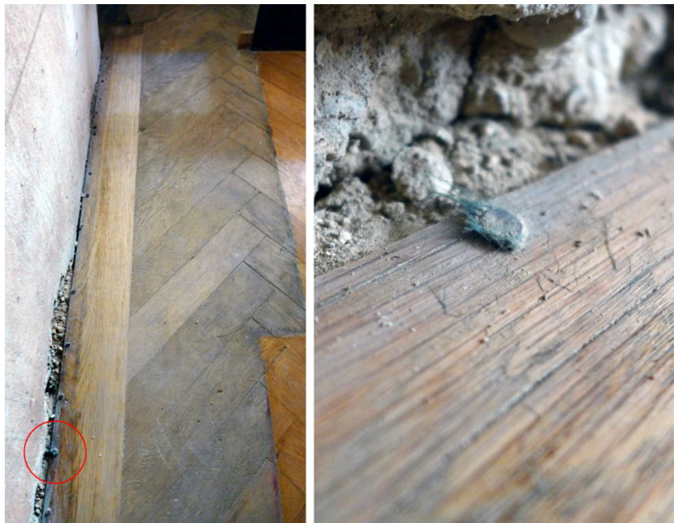
Abb. 10: Spuren früherer Fassungen an den Wänden von Zimmer 1: an der Kaminwand Spuren des Aufbaus des Vorgängerkamins, in der Raumecke Spuren eines Gipsfeilers
