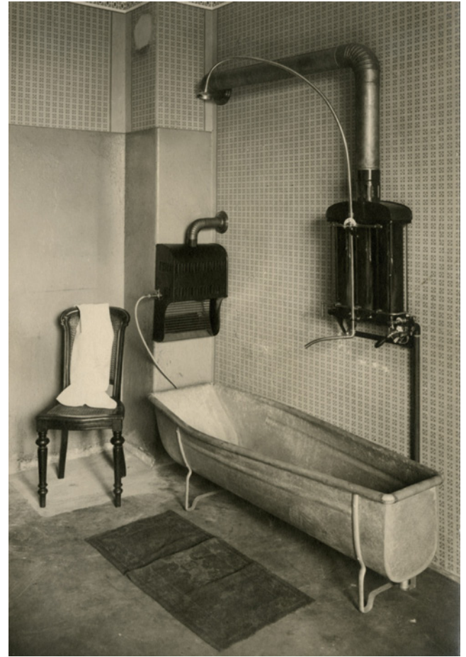
Abb. 13: Einblick in ein Badezimmer mit Badewanne, Duschkopf und Speicher, Fotografie 15 x 21,7 cm, Technisches Museum Wien
