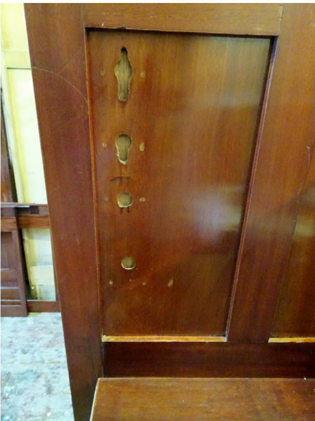
Abb. 10: Fehlende Schalter
