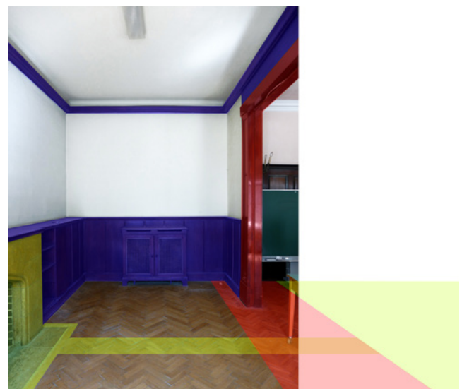
Abb. 2: Umbauphasen Zimmer 3: gründerzeitliche Zusammenlegung zweier Kabinette und Kamineinbau (gelb), 1921 – Versetzung der Zwischenwand und breite Öffnung, 1930er Jahre – wandfeste Einbauten
