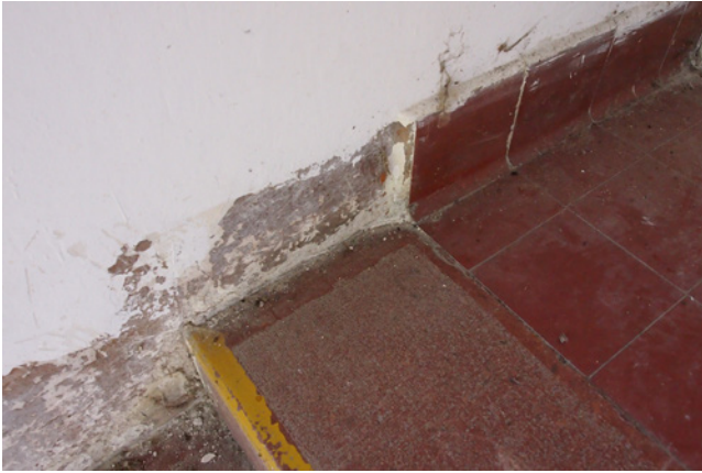
Abb. 11a: Original rote Terrazzotreppen und Keramikfliesen in der Eingangsnische (Nordfassade), Aufnahme 2021, Museum der Stadt Brünn
