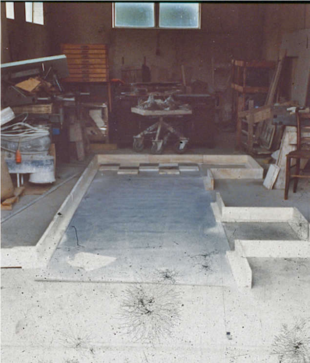
Abb. 7: Neuerstellung des zerstörten Fußbodens, Randfrieße und die Bodenplatten hinten sind der einzige gerettete Altbestand
