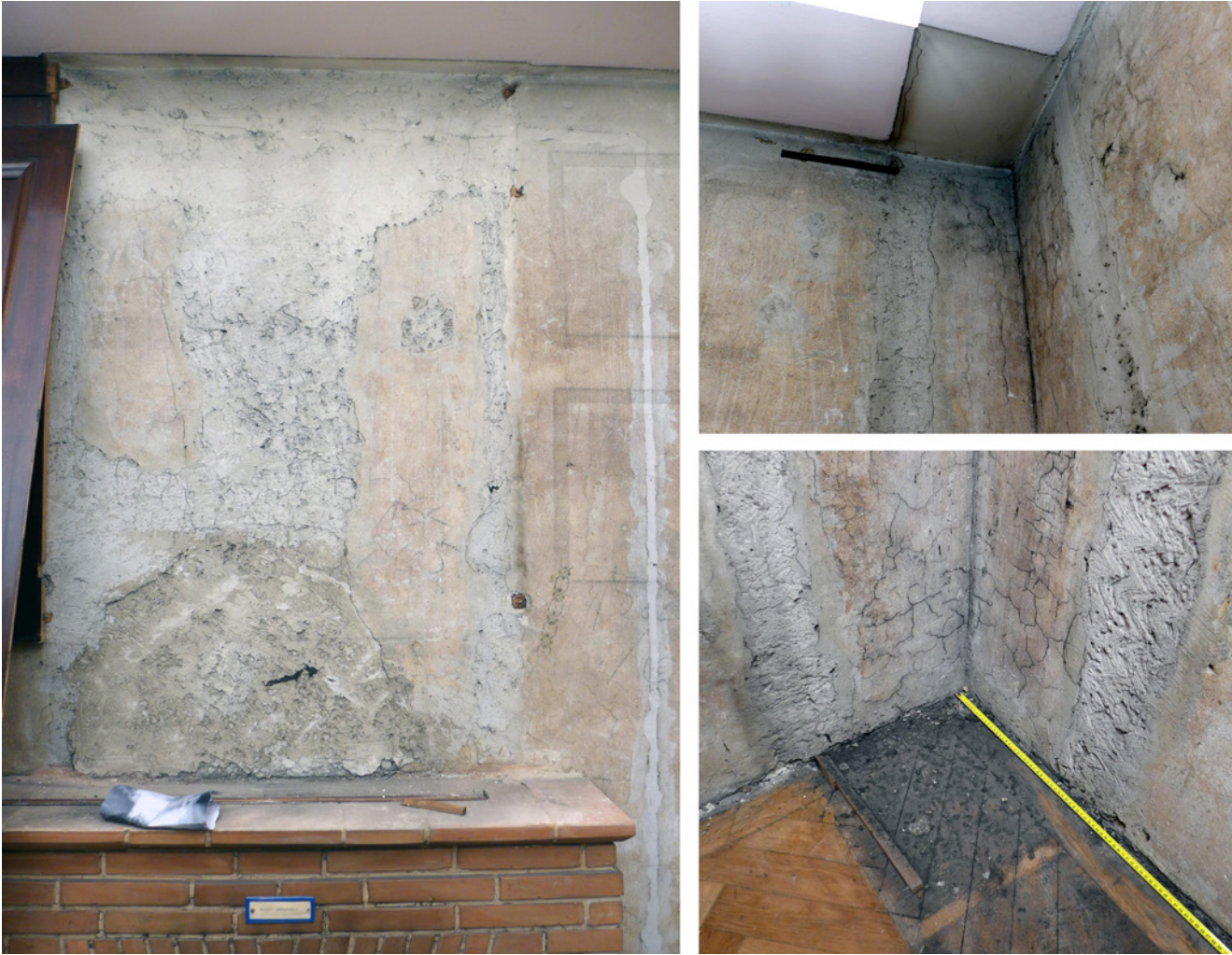
Abb. 10: Spuren früherer Fassungen an den Wänden von Zimmer 1: an der Kaminwand Spuren des Aufbaus des Vorgängerkamins, in der Raumecke Spuren eines Gipsfeilers
