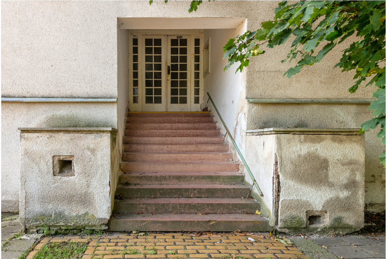
Abb. 13a: Treppennische des Haupteingangs mit dem Originalpflaster des Zufahrtsweges, Aufnahme 2020, Museum der Stadt Brunn
