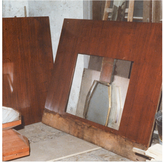
Abb. 9: Die Wandpaneele nach ihrer Restaurierung und vor der Wiederanbringung
