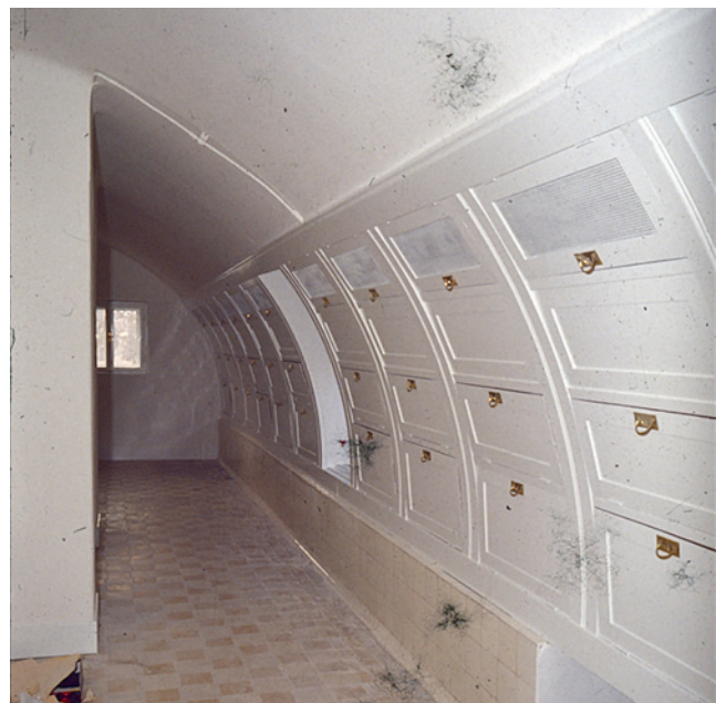
Abb. 4: Der „Eisenbahnwaggon“, restauriertes Dachgeschoß des Hauses Strasser mit eingebauten Schubladen in der Dachkonstruktion
