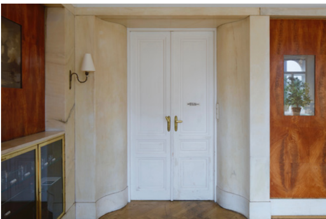
Abb. 7: Türeinfassung im Wohnsalon, S-förmig geschliffen in Carrara-Marmor, Adolf Loos
