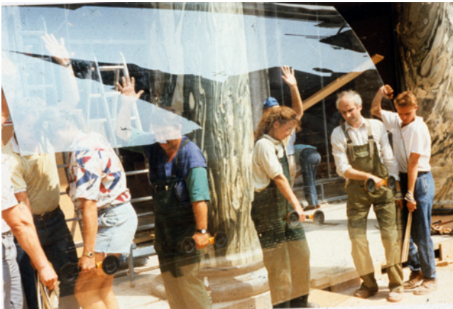
Abb. 15: Einsetzen der gebogenen Scheiben durch die Firma Rigoglas, in der Mitte Frau Liebentritt, die Inhaberin, rechts ihr Mann und einer ihrer Söhne
