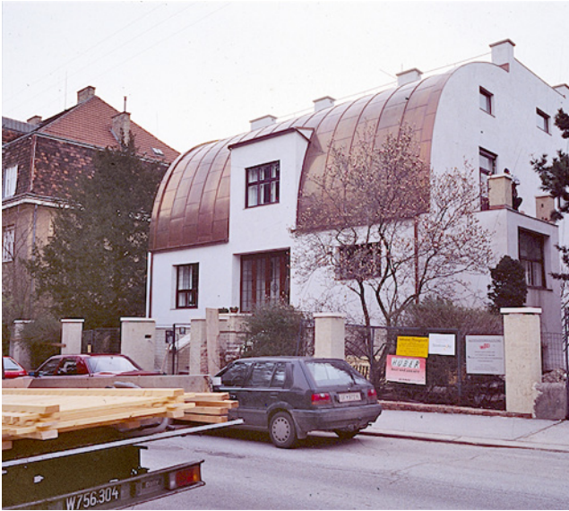
Abb. 3: Straßenfassade des Hauses Steiner nach der Rekonstruktion
