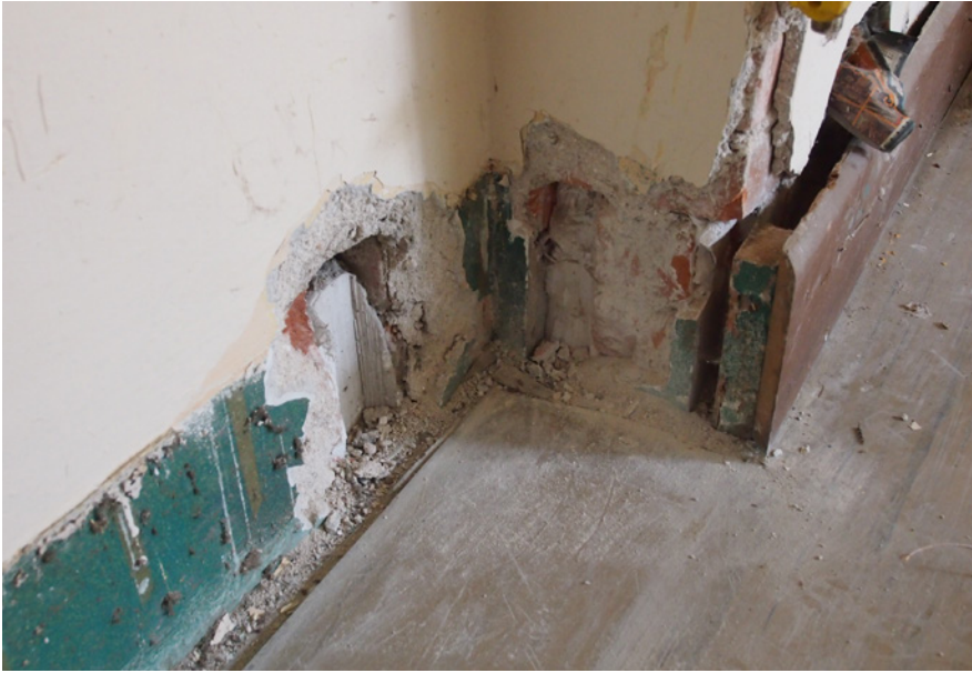
Abb. 14a: Grüne Bemalung unter dem Fragment der hölzernen Sockelleiste im Zimmer Nr. 8 (Bibliothek) im Hochparterre, Aufnahme 2021, Museum der Stadt Brünn
