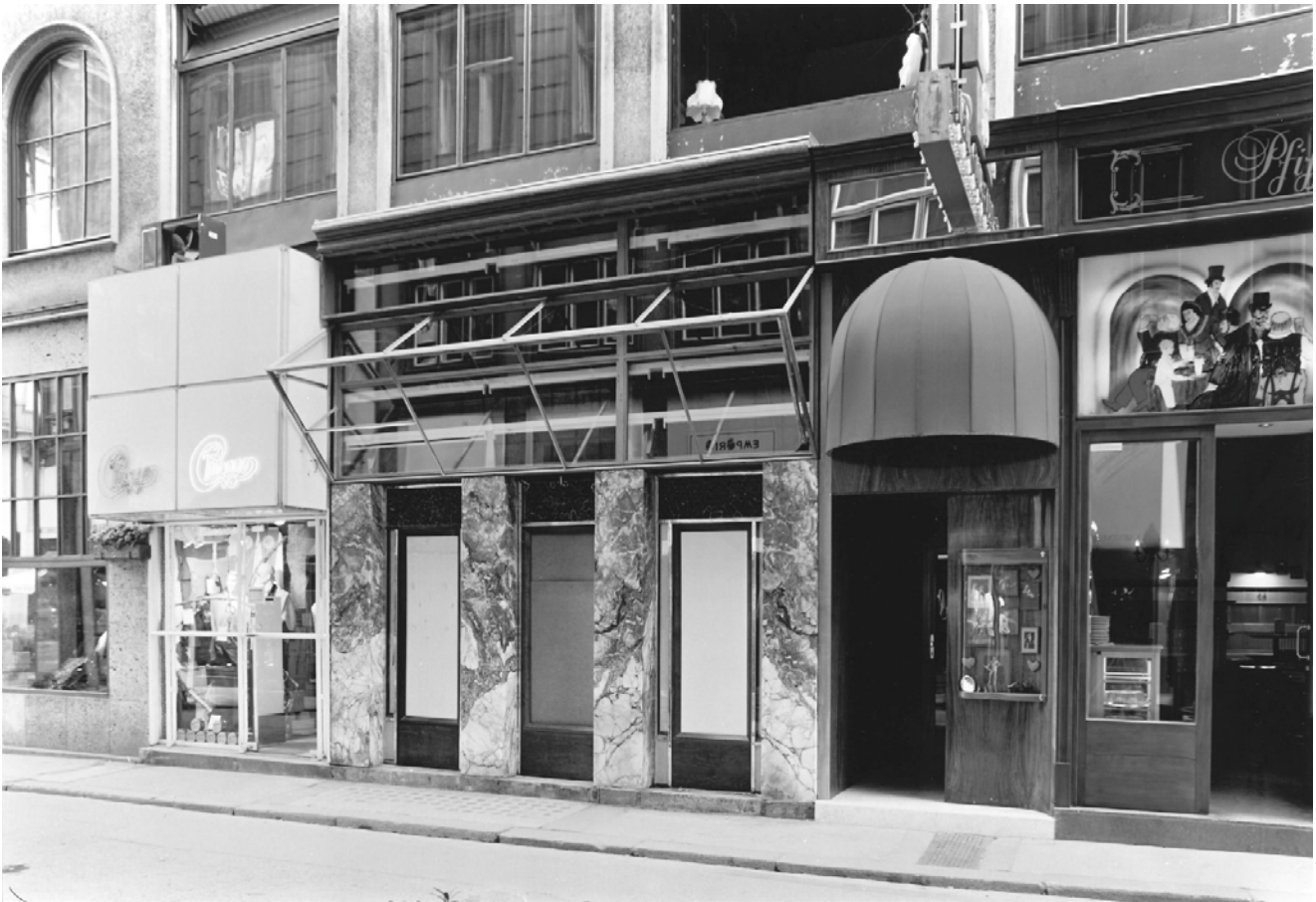
Abb. 31: Vor der Montage der Schilder 1989 war die ursprüngliche Portalzone der Gebäudefront rechts (westlich) der Loos-Bar rekonstruiert worden, jedoch maßlich ungenau, vereinfacht und vor allem unter Weglassung des Zinkblechprofils. Diese falsch rekonstruierte Portalzone entspricht deshalb nicht dem akkurat rekonstruierten oberen Schildkasten des Loos-Portals mit der Aufschrift „American Bar“. – An der Unterseite des Prismenschildes bestehen die Flächen der Schrift und des „Sternenfelds“ der dargestellten USA-Flagge aus gefassten Bruchglasstücken (siehe Abb. 29). Um diese Flächen zum Glitzern zu bringen, sind punktförmige Lichtquellen, also klare Glühlampen, erforderlich. Schon 1989, bei der Montage am Ort, wurden Leuchtstoffröhren installiert; derzeit sind punktförmige Leuchtmittel gar nicht mehr handelsüblich. 12
