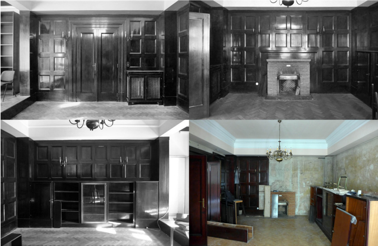
Abb. 5: Ehemaliges Speisezimmer Boskovits bzw. Arbeitszimmer Gardiner (Zimmer 1): Wandverkleidungen – Abnahme im Rahmen der Begutachtung 2014
