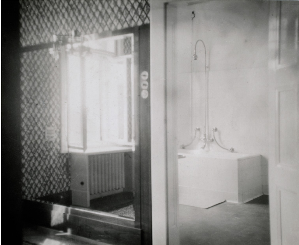
Abb. 7a: Badezimmer im Obergeschoss, Ansicht vom Ankleidezimmer, Aufnahme April 1916
