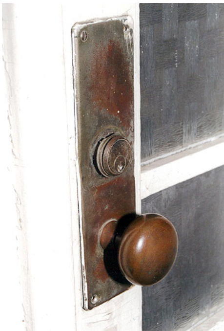
Abb. 13b: Messingbeschlag und Knauf der Eingangstür (nicht erhalten), Aufnahme 2003, Museum der Stadt Brunn
