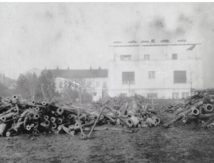
Abb. 2a: Südfassade nach dem Brand des Fabrikgebäudes, Aufnahme Jänner 1916
