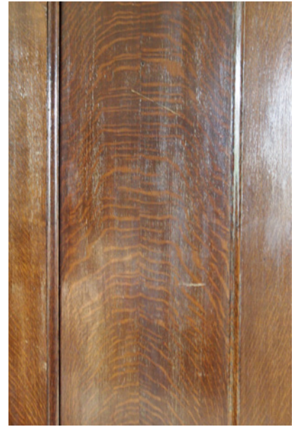
Abb. 14b: Furnierdetail (Nussbaumholz) der Wandtäfelung der Aufgangshalle, Aufnahme 2021, Museum der Stadt Brünn
