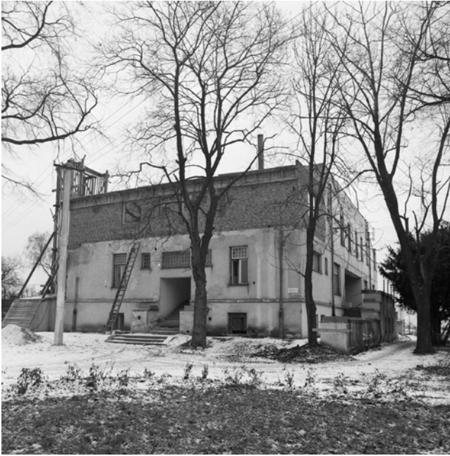
Abb. 6a: Ansicht der Villa von Nordwest, Aufnahme 24. Jänner 1968
