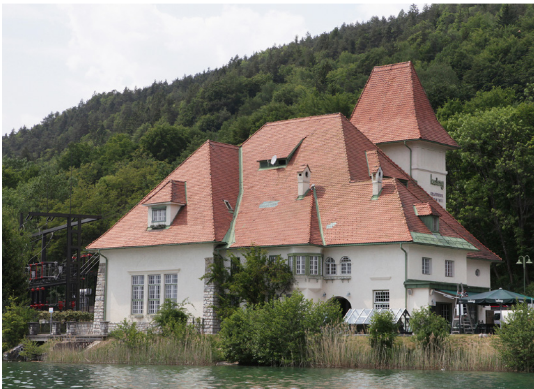
Abb. 24: Saag, Forstseekraftwerk (Denkmalschutz seit 1996), 1923–1925, Architekt Franz Baumgartner
