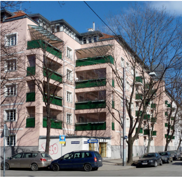
Abb. 6: Wien, Winarsky-Hof, Josef Frank 1924-25, Sanierung mit Außendämmung, Fenstertausch und Dachgeschoßausbau 2005–2008
