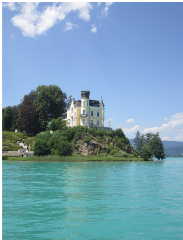
Abb. 1: Reifnitz, „Schloss Klein Miramar“ (Denkmalschutz gemäß Verordnung 2002), 1898, Architekt Zekonski
