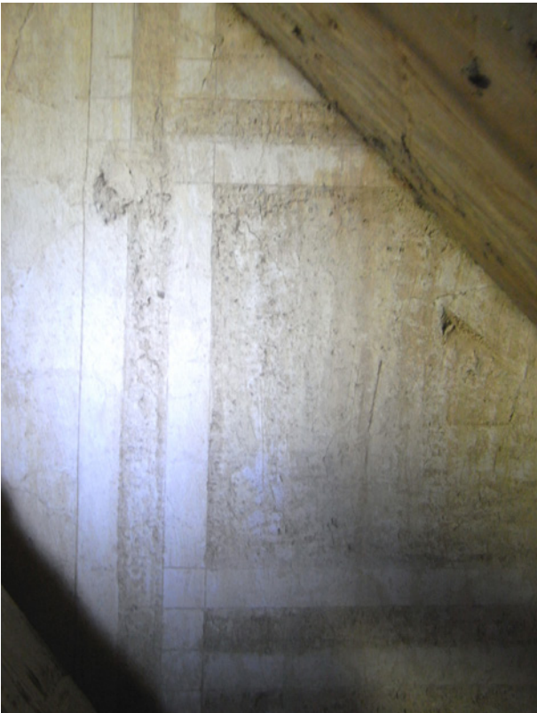
Abb. 22: Vorau, Vorgebäude, Torturm 1619 (Südseite, heute Dachboden): Fassadengestaltung mit Putzgraffito, ursprünglicher Zustand 2015
