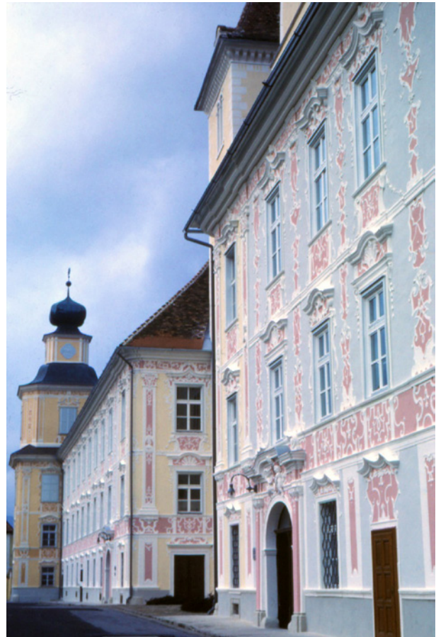
Abb. 23: Vorau, Westfassaden von Stift und Kirche, um 1728, nach Befundrestaurierung von 1987: Vierfarbigkeit mit symmetrischem Farbwechsel der Achsen neben der Kirche und bei den Ecktürmen, der bei der Folgerestaurierung 2012 leider weggelassen wurde
