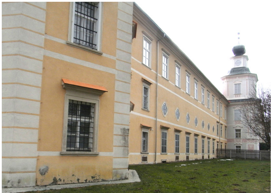
Abb. 21: Vorau, Stift, Prälaturtrakt, Nordostecke der Außenfront: ursprünglich weiße Putzgraffitofassade mit aufgerauten Wandflächen und eingekratzten weißen Gliederungen; der Zustand 2015 tradiert die Fehlinterpretation des 19. Jahrhunderts
