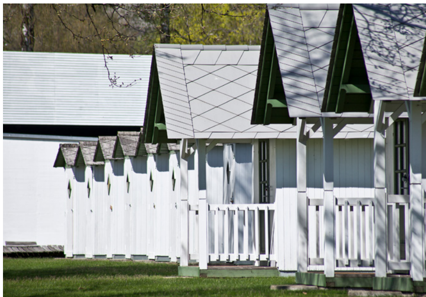
Abb. 11: Klagenfurt am Wörthersee, Strandbad (Denkmalschutz gemäß Nachtragsverordnung vom 10.12.2008), 1927–1929, Architekten Franz Koppelhuber und Paul Theer, 1959/60 Erweiterung, Kabinenhäuschen
