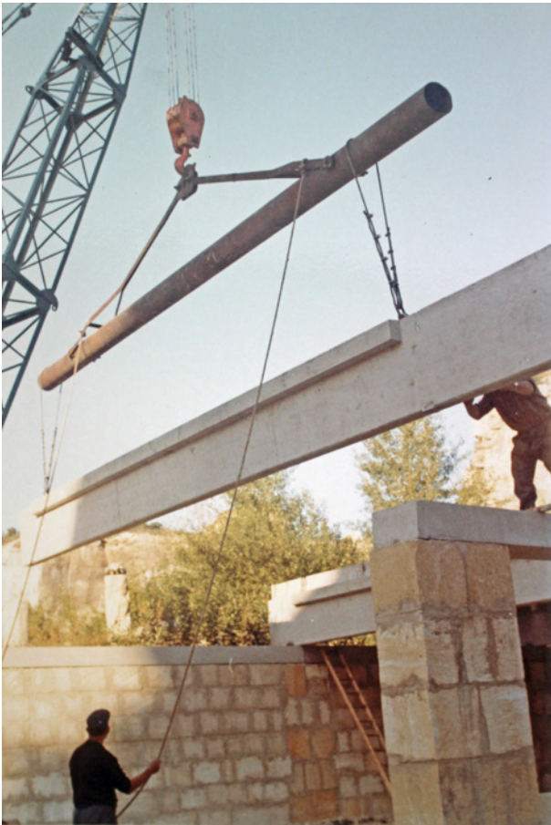
Abb. 8: Montage der Fertigteilträger
