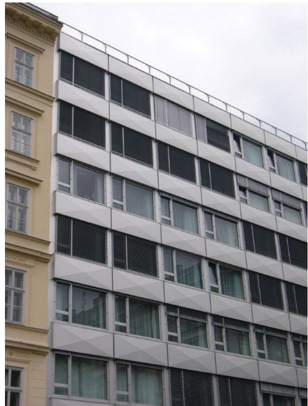
Abb. 9: Wien, Böhlerhaus, Roland Rainer 1956–1958, Umbau/ Fassaderenerneuerung 2003
