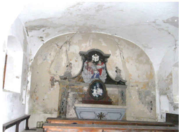
Abb. 5: Altarraum vor Restaurierung
