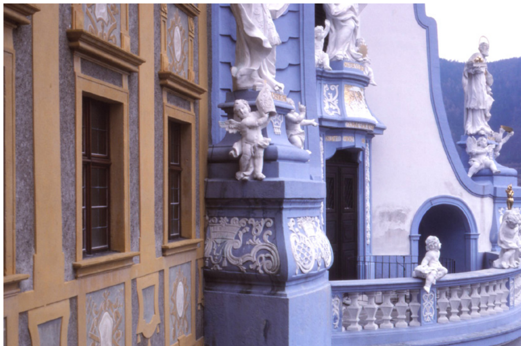
Abb. 5: Dürnstein, Westfassade des Prälaturtraktes und Turmaltane, nach Restaurierung 1986
