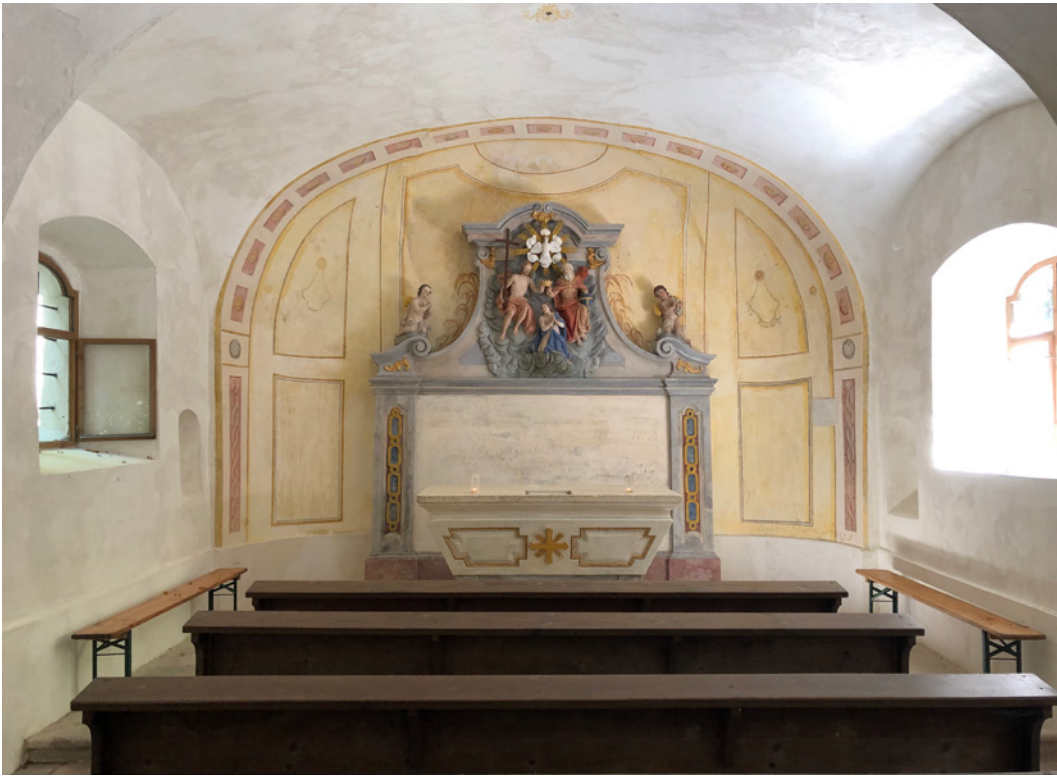
Abb. 15: Apsiskalotte, Wandmalerei nach Freilegung und Restaurierung
