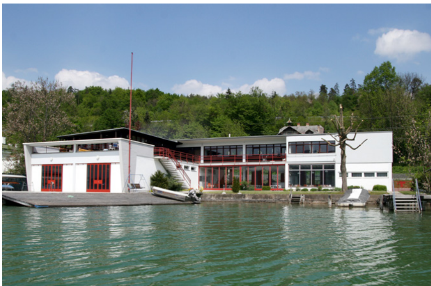
Abb. 13: Klagenfurt am Wörthersee, Clubhaus Ruderverein „Nautilus“ (noch kein Denkmalschutz), 1960, Architekt Rolf Haas
