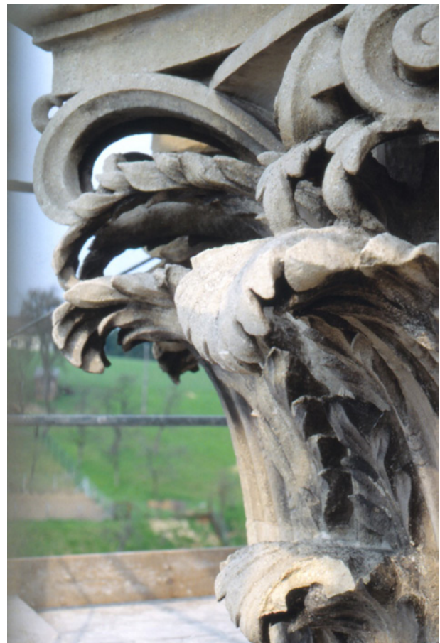
Abb. 18: St. Florian, Stiftskirche, Fassade, Nordwestecke: komposites Eckkapitell ohne stärkere Verwitterung, vor Restaurierung 1993
