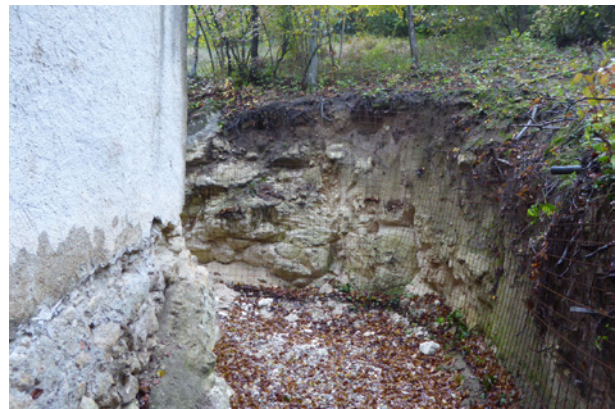
Abb. 4: Ansicht der Nordostecke der Kapelle mit rezenter Hangabgrabung
