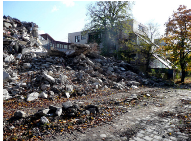
Abb. 3: Wien, Stadt des Kindes, Anton Schweighofer 1969–1974, Zerstörung 2008
