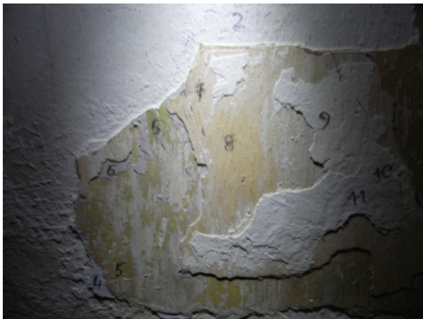
Abb. 6: Altarraum, Südostecke neben Fenster, Schichtenbefund der Wandtünchen
