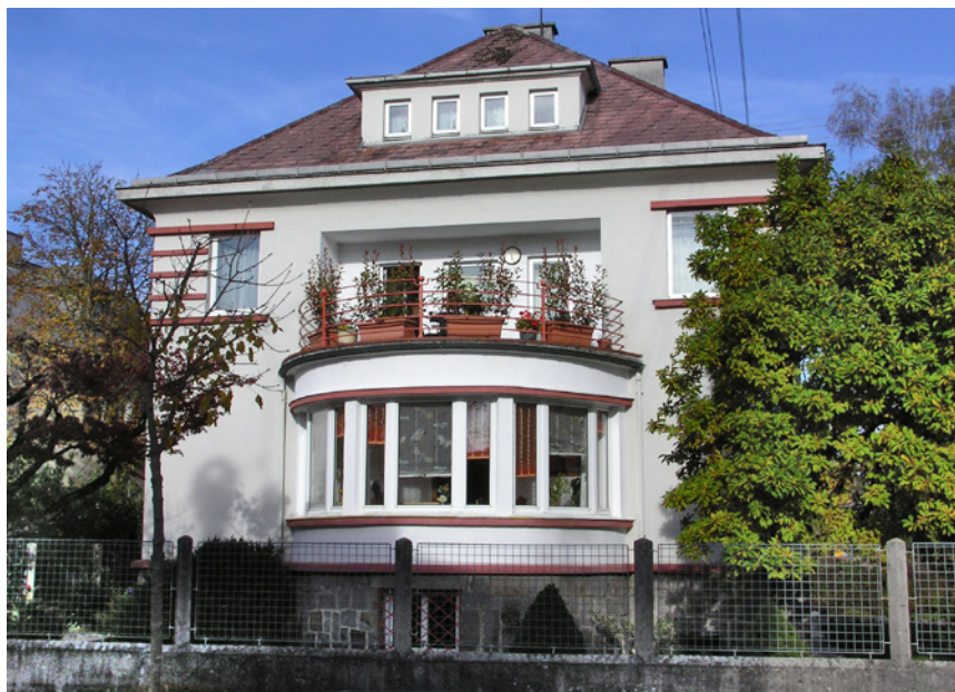
Abb. 2: Vöcklabruck, Klosterstraße 1, Haus Reiter, errichtet von Hermann Aichinger 1929
