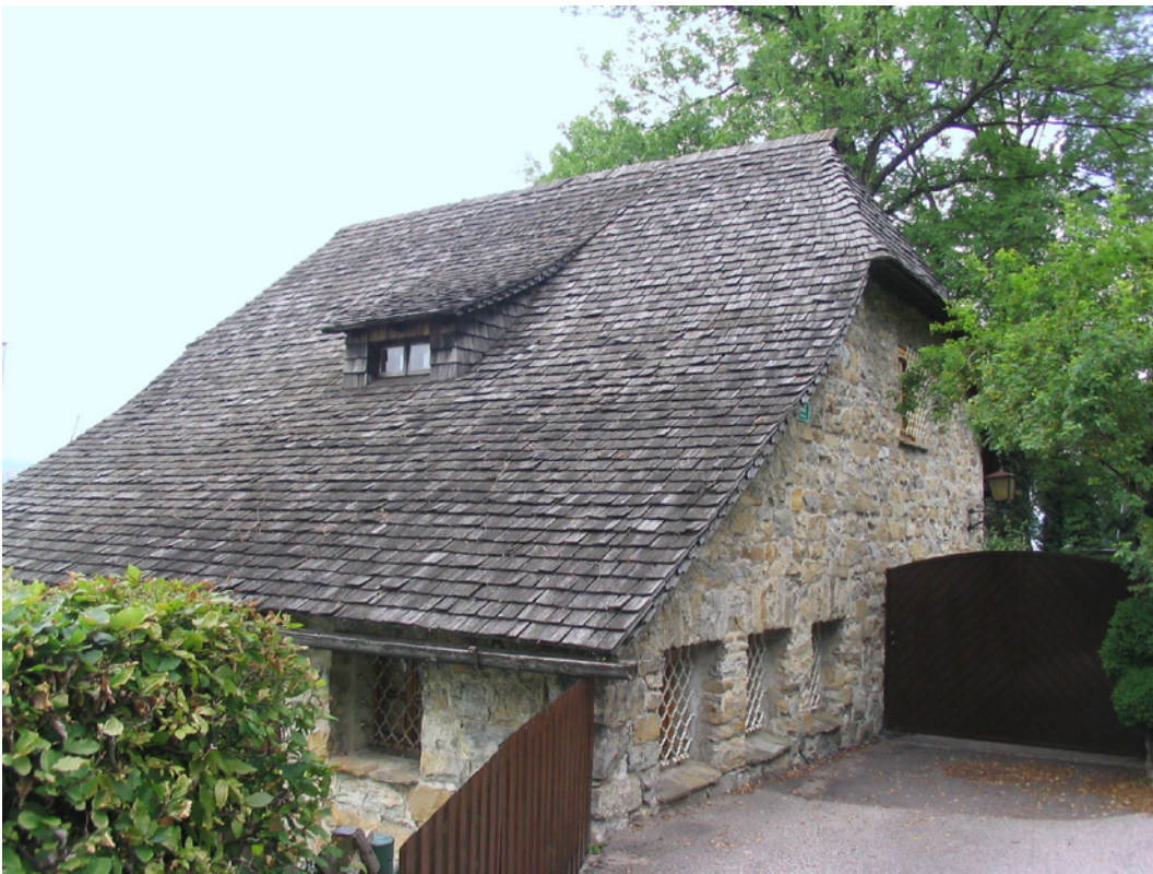
Abb. 5: Weyregg, Seeberg 63, errichtet von Leo Keller in den Jahren 1948/49
