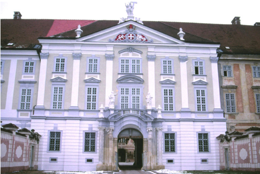
Abb. 7: Herzogenburg, Stift: Eingangsrisalit der Nordfassade während Restaurierung der Erstfassung
