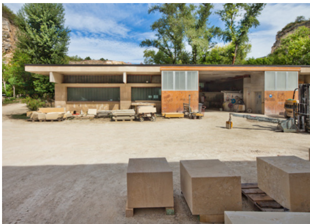
Abb. 12: Ansicht von Süden mit umgebautem Mitteltrakt und Schiebetoren
