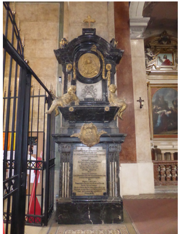
Abb. 15: Grabmal Metsch im Zustand vor der Restaurierung
