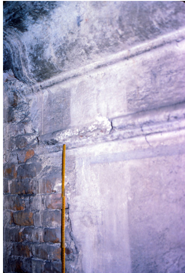
Abb. 2: St. Pölten, Dachboden: Hauptgesims im Zustand von um 1650 mit radiertem Streifen: Weißes Putzgesims mit darunter vorgeritztem, grauem Schattenband
