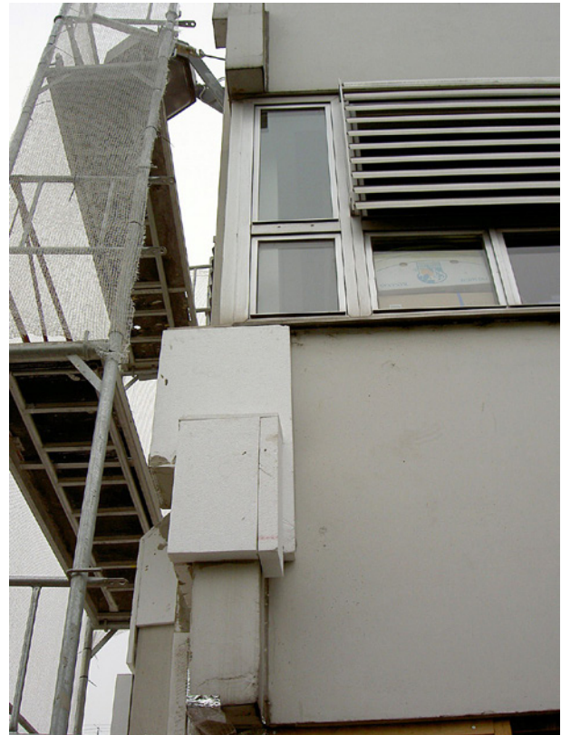
Abb. 7: Musterfassade, die der ORF im Herbst 2005 auf dem Bauteil 3 ausführen ließ
