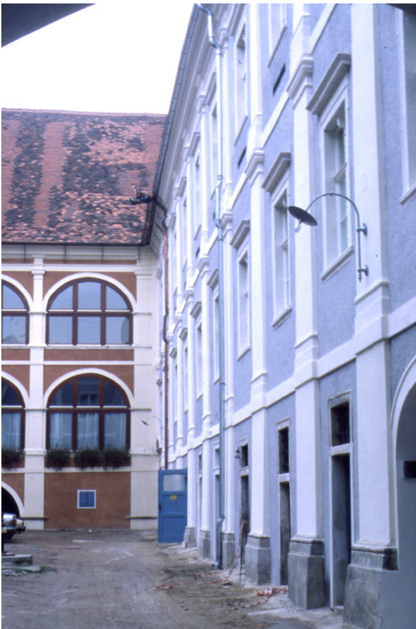
Abb. 25: Pöllau, kleiner ehem. Stiftshof, nach teilweiser Restaurierung auf die Erstfassung mit glatt-weißen Gliederungen und grauem Rauputz mit Hammerschlag (spätere Rostverfärbung!) auf den Wandfeldern 1987
