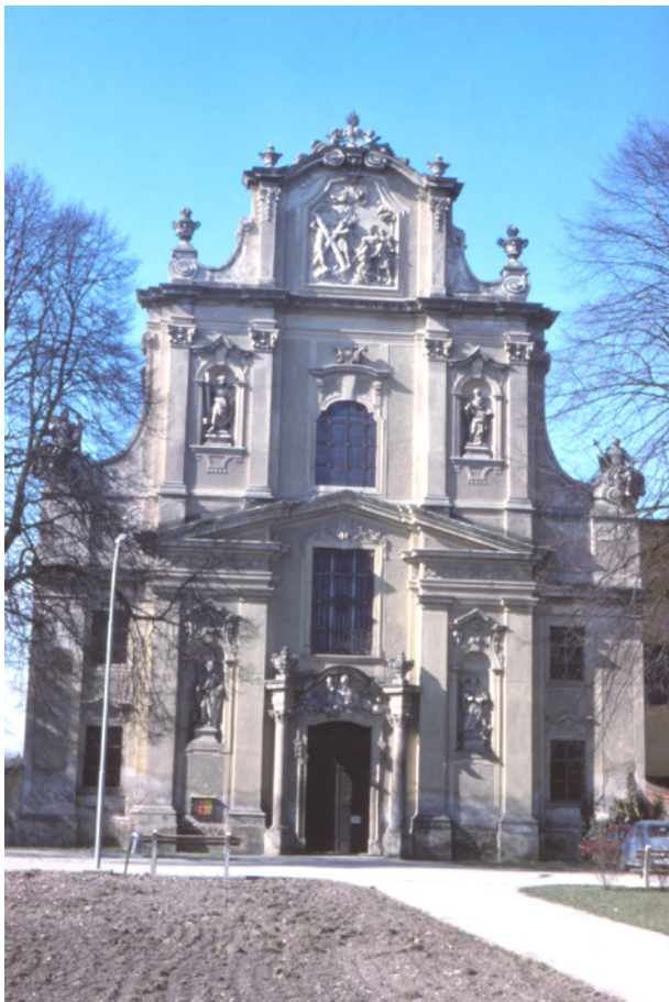
Abb. 11: St. André an der Traisen, ehem. Stiftskirche: Ostfassade, vor Restaurierung 1978
