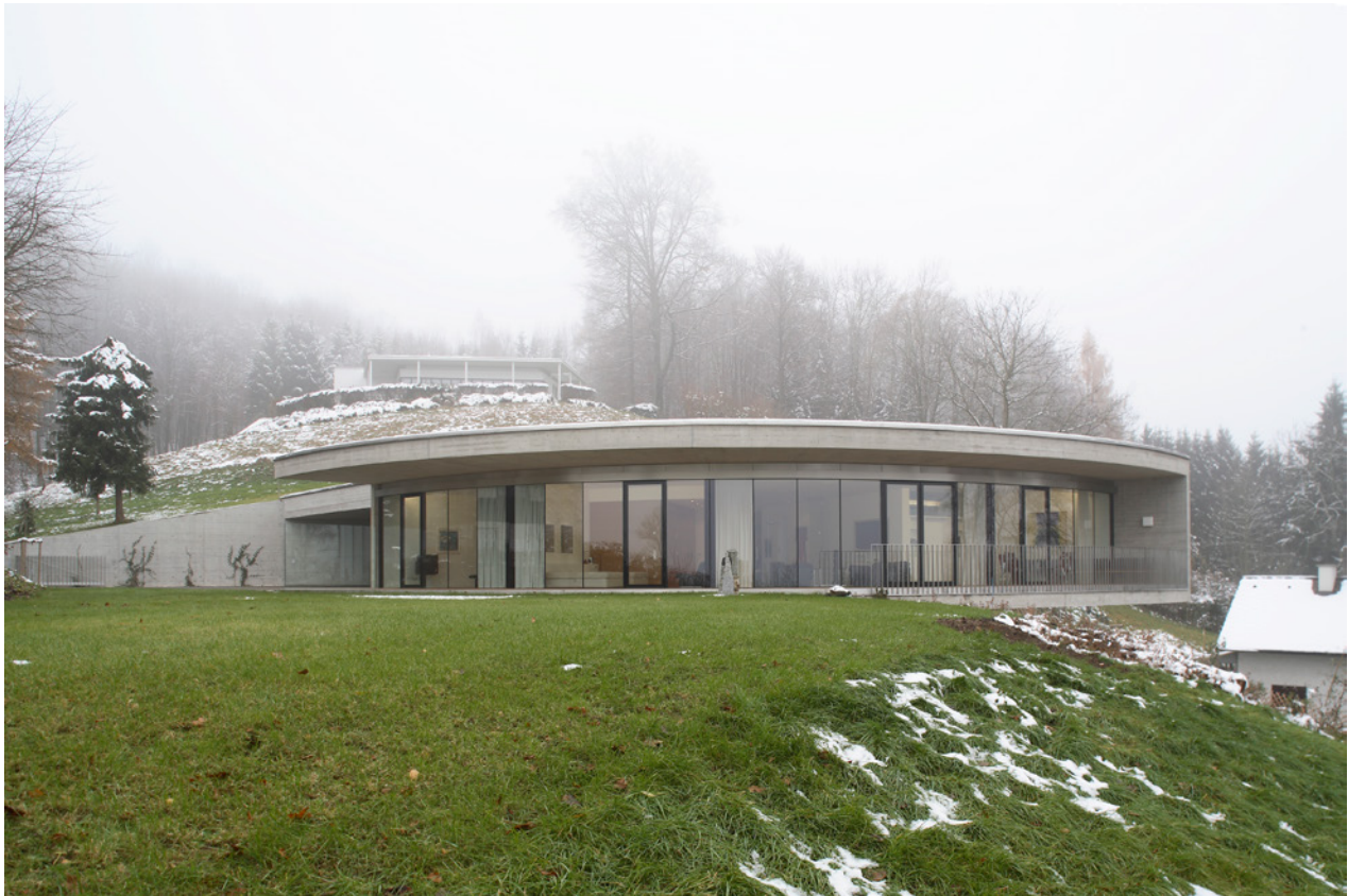
Abb. 8: Seewalchen, Unterbuchberg 42, Haus F., errichtet von Luger & Maul 2005–2008, Ansicht mit Haus Gamerith von Ernst Plischke im Hintergrund, rechts unten: Grundriss des Erdgeschosses
