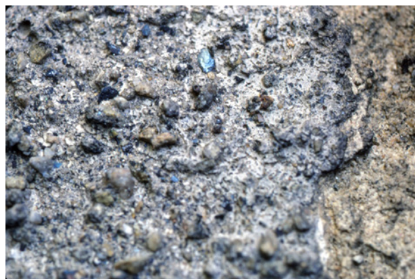
Abb. 6: Dürnstein, Unterbau des Turmes der Stiftskirche: Strukturputz der Rustikabänderung, mit schwarzem Hammerschlag eingefärbt
