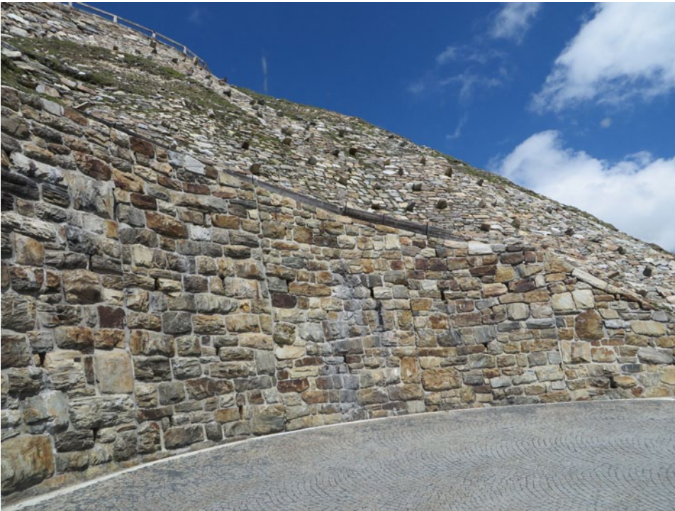
88. Großglockner Hochalpenstraße, Salzburg / Kärnten, Stützmauerwerk der 1930er Jahre
