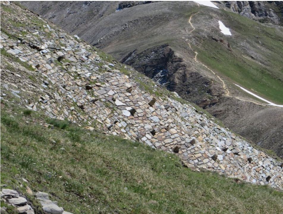
91. Großglockner Hochalpenstraße, Salzburg / Kärnten, Hangsicherung mit trocken verlegtem Steinsatz und aufragenden Steinen als Lawinenschutz
