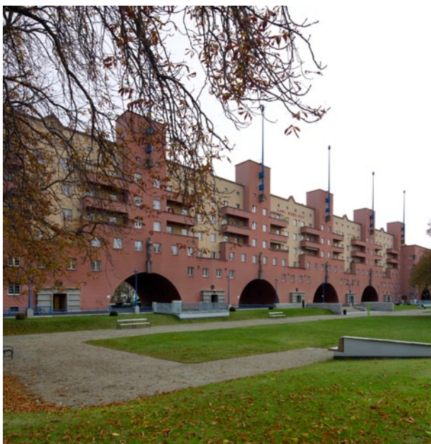
10. Wien 19, Heiligenstädter Straße 82–92, Karl-Marx-Hof, errichtet 1927 bis 1930 von Karl Ehn
