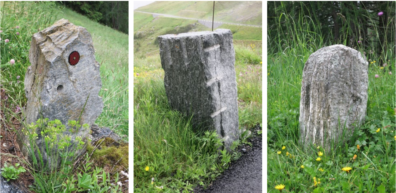
93a, b, c. Großglockner Hochalpenstraße, Salzburg / Kärnten, unterschiedlich geformte, bauzeitliche Randsteine
