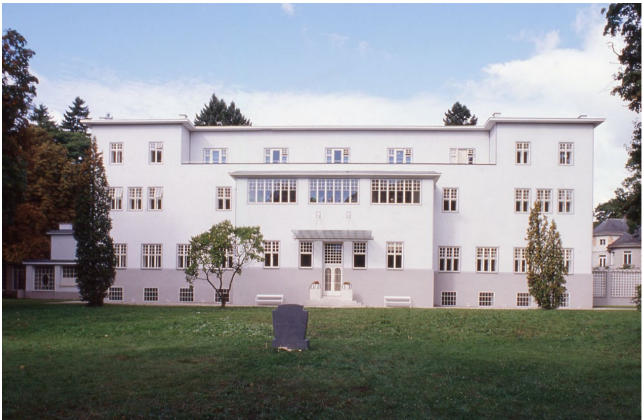
11b. Purkersdorf, Niederösterreich, Sanatorium errichtet von Josef Hoffmann in den Jahren 1904 bis 1905, nach Restaurierung und Rückführung auf den Vorzustand
