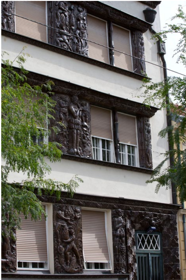
6. Wien 13, Wattmangasse 29, Schokoladenhaus, errichtet von Ernst Lichtblau 1914
