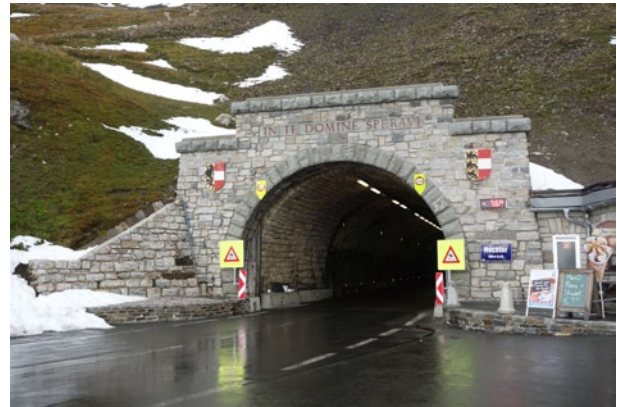
96. Großglockner Hochalpenstraße, Salzburg / Kärnten, Südportal des Hochtortunnels mit geöffneten Schiebetoren
