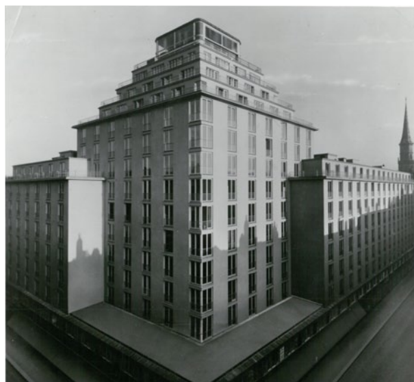
2. Wien 1, Herrngasse 6-8, Hochhaus errichtet von Siegfried Theiß & Hans Jaksch in den Jahren 1931 bis 1932, historische Aufnahme
