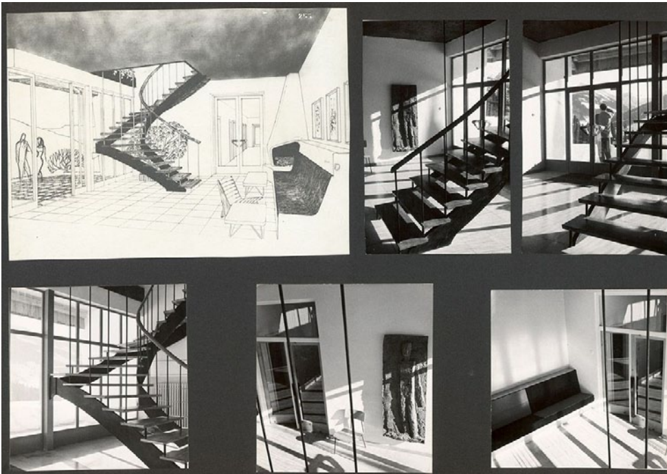
32. Ferdinand Kitt, Paula-Preradović Haus, Alpbach, 1951–1953, Eingangsbereich, Architekturzentrum Wien, Sammlung
