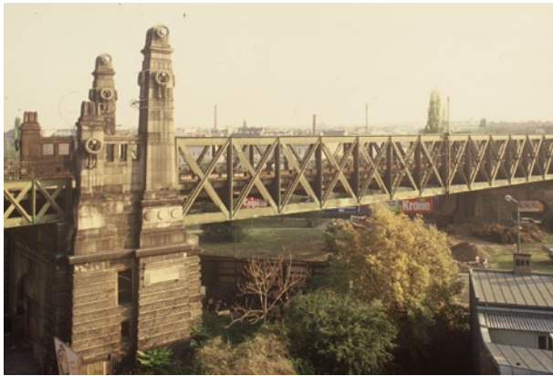
8a. Wien 12, Otto Wagner Stadtbahnbrücke über die Wienzeile, errichtet 1896/97, historische Aufnahme
