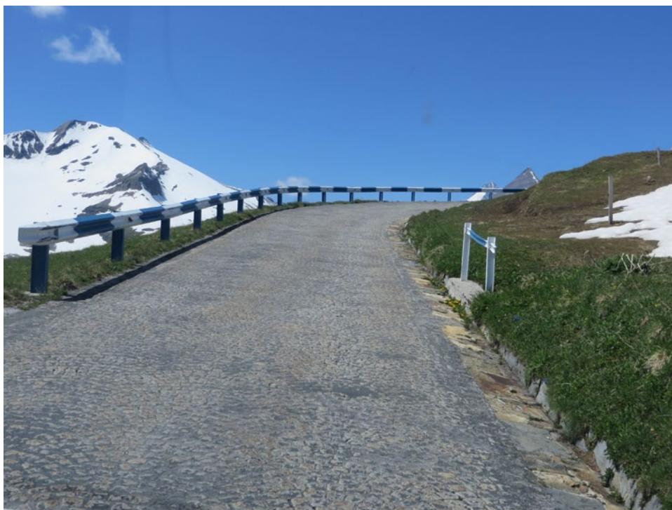
87. Großglockner Hochalpenstraße, Salzburg / Kärnten, Pflasterung im Abschnitt der Edelweißstraße
