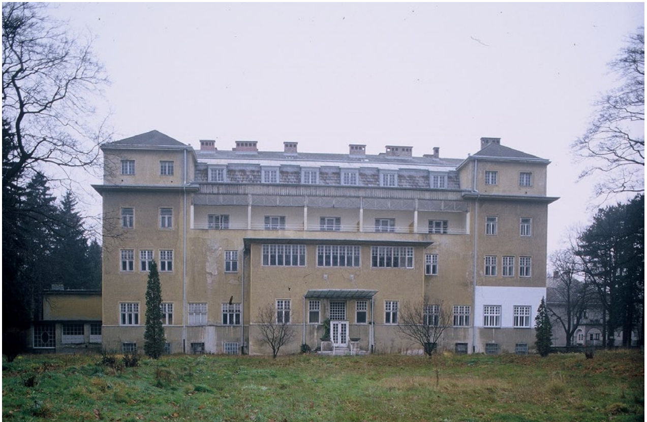
Abb. 11a. Purkersdorf, Niederösterreich, Sanatorium, errichtet von Josef Hoffmann in den Jahren 1904 bis 1905, mit Aufstockung durch Leopold Bauer von 1926
