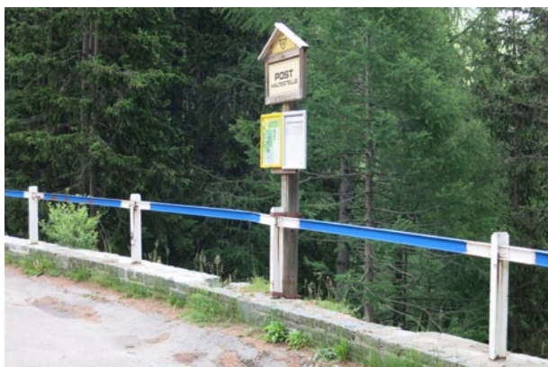
92a. Großglockner Hochalpenstraße, Salzburg / Kärnten, historische Metallleitplanke aus den 1930er Jahren
