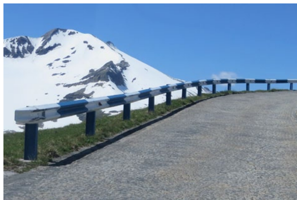
92b. Großglockner Hochalpenstraße, Salzburg / Kärnten, Leitplanke der 1950/60er Jahre auf der Edelweißstraße
