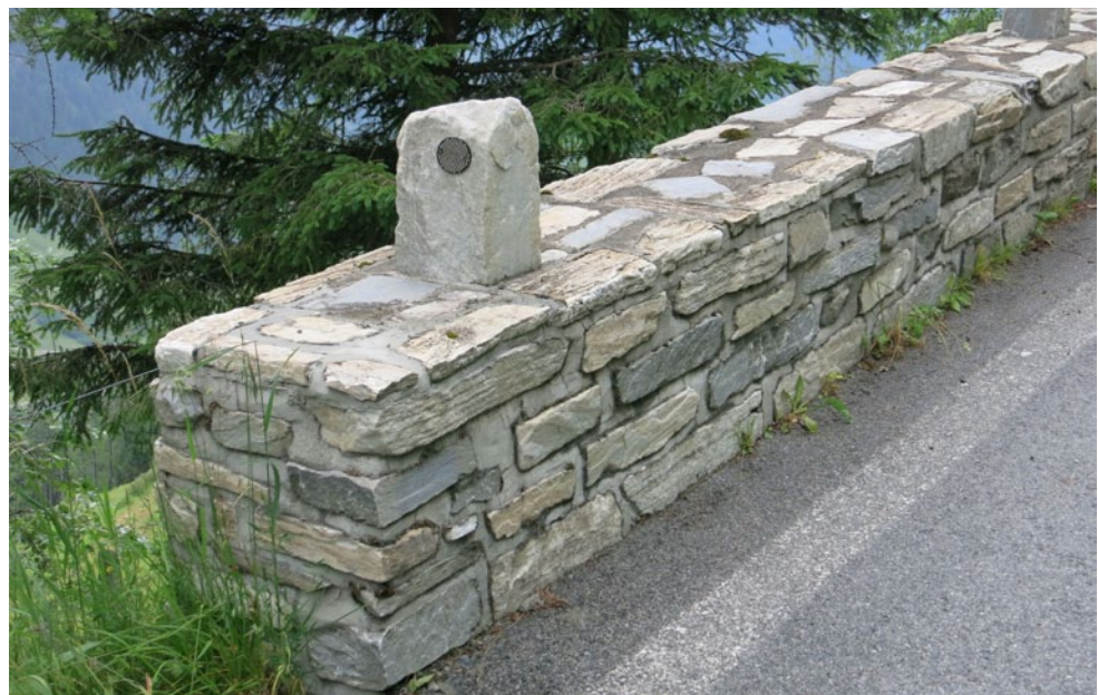
90. Großglockner Hochalpenstraße, Salzburg / Kärnten, Brüstungsmauer mit eingelassenem Randstein
