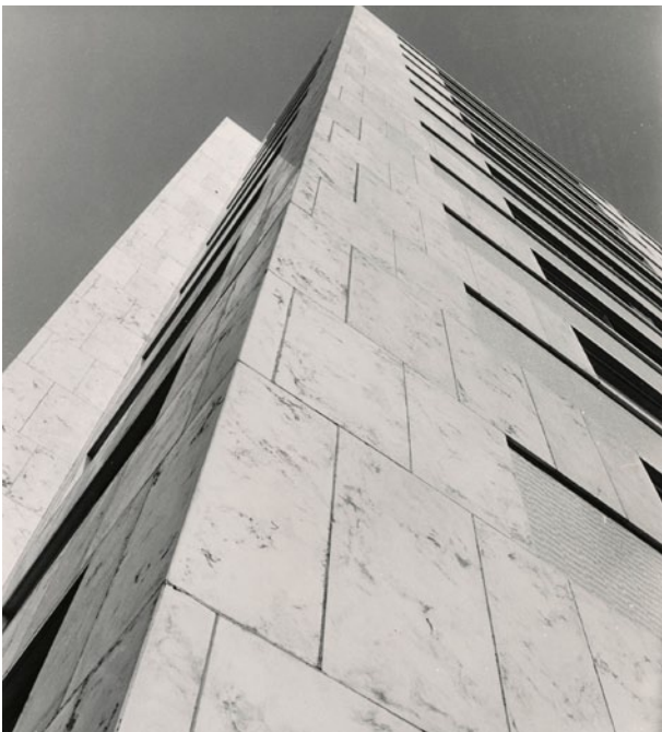
36. Wien 3, Johannesgasse 28, Hotel InterContinental, errichtet 1959–1964 von Carl Appel, Walter Jaksch, Holo Bird & Root, Kassettieren der Kunststeinfassade mit Glasmosaikfeldern, Architekturzentrum Wien, Sammlung
