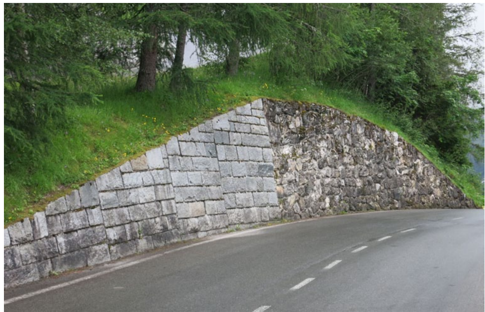
89. Großglockner Hochalpenstraße, Salzburg / Kärnten, Mauerwerkstypen unterschiedlicher Zeitstellungen
