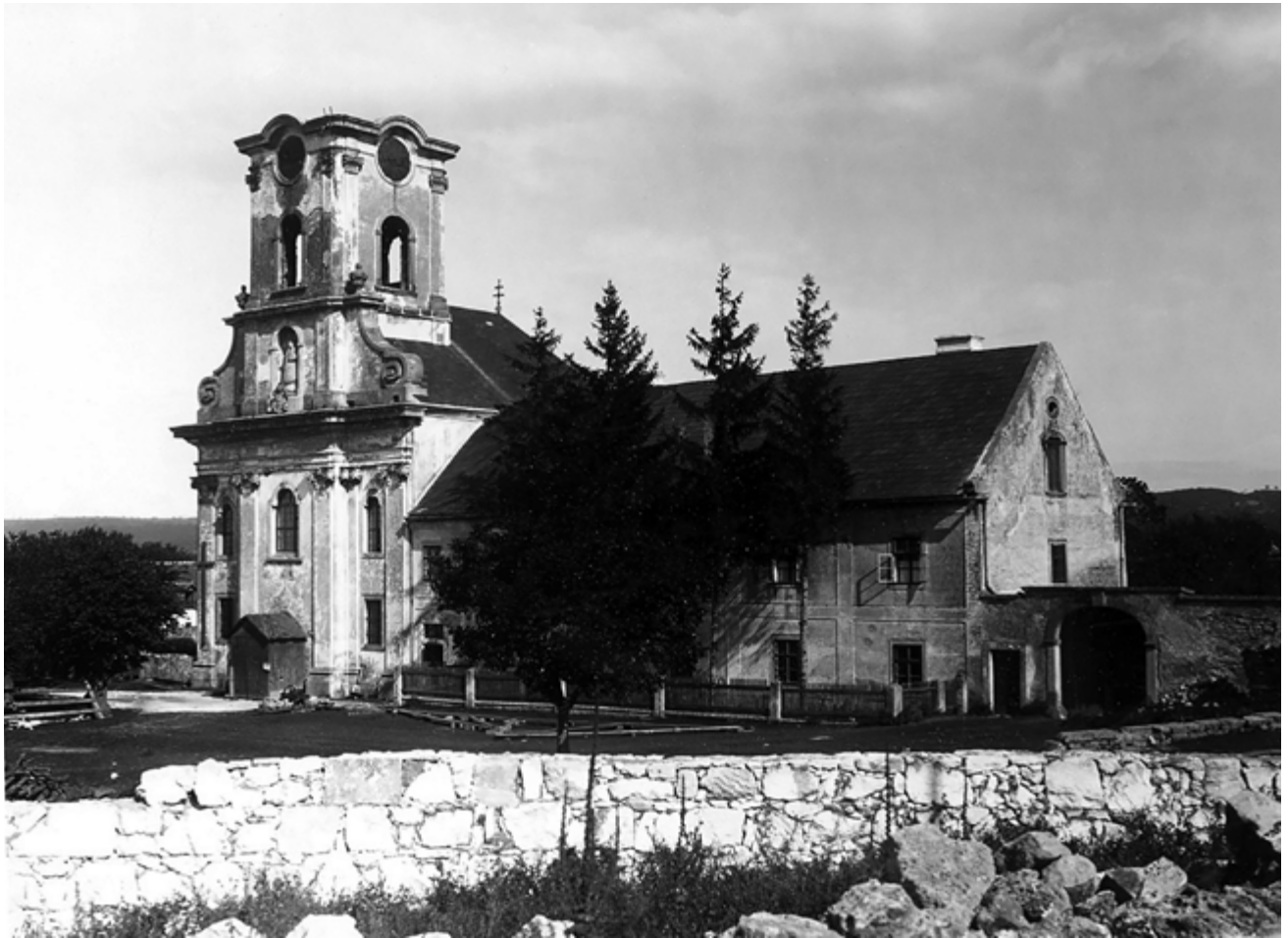
Zustand nach dem Brand 1930
