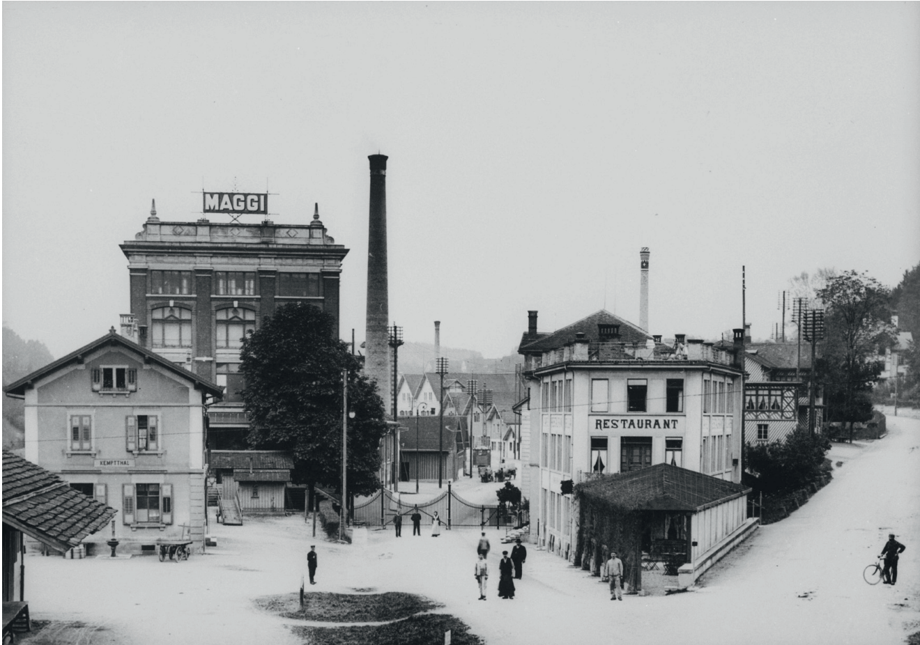
Abb. 1: Lindau, Kanton Zürich, nördlicher Zugang zum ehemaligen Fabrikareal Maggi (heute: The Valley) in einer historischen Aufnahme
