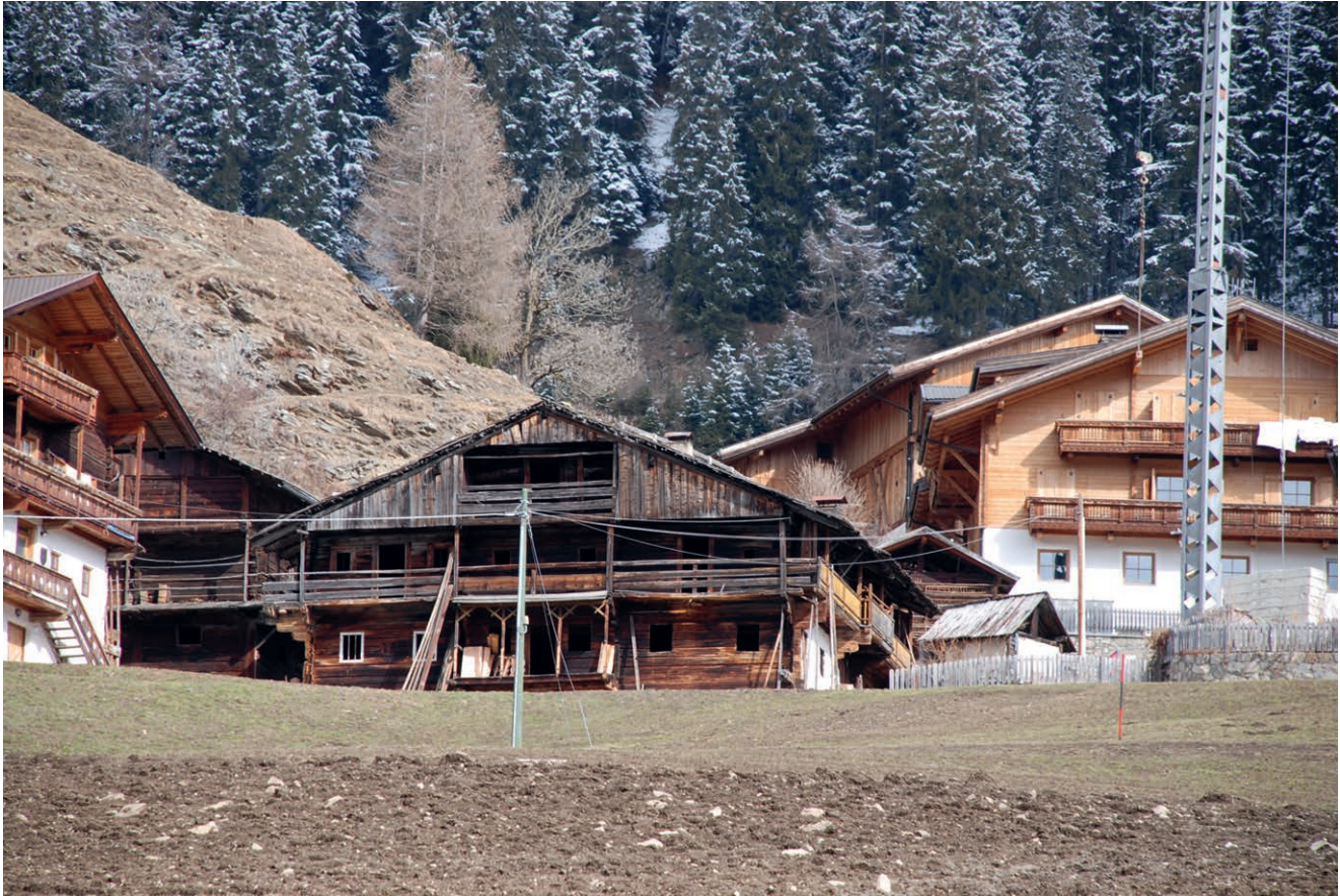
Abb. 1: Südtirol, Veidlerhof St. Magdalena Gsies vor dem Umbau
