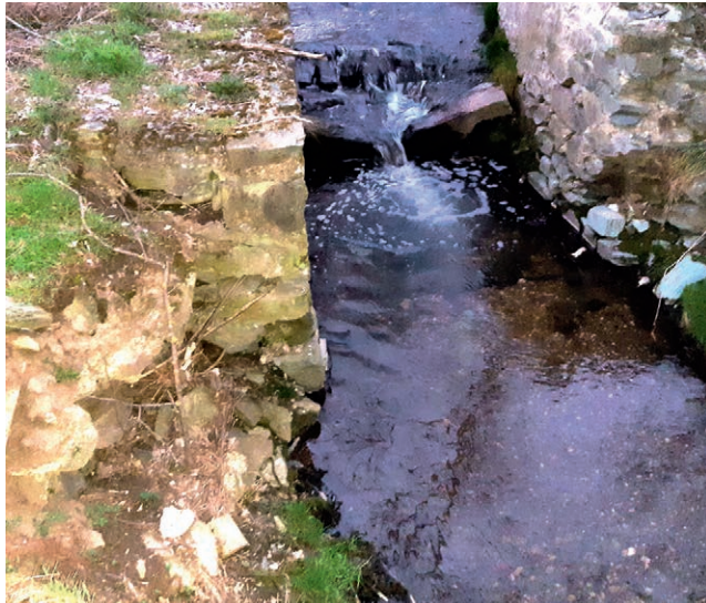
Abb. 4: Querung der Wasserleitung im regulierten Bett des Rechnitzbaches, römische Bruchsteinmauer links im Vordergrund
