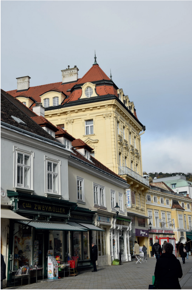
Abb. 2: Mercedeshof, Baden, Ansicht von Südosten, Hauptplatz
