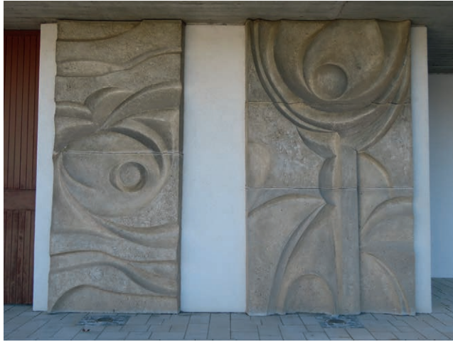
Abb. 2: Filialkirche Aderklaa, zwei der vier Betonreliefs am Hauptportal
