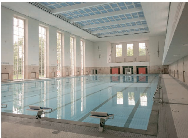
Abb. 8: Schwimmhalle Finckensteinallee Berlin Lichterfelde nach der Sanierung, 2014
