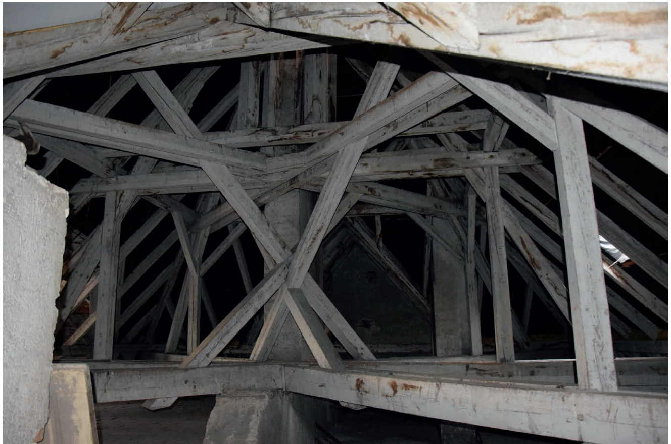
Abb. 4: Mercedeshof, Baden, Detail Dachkonstruktion
