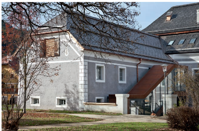
Abb. 10: Ansicht der gartenseitigen Fassade mit neuem Stiegenhaus, Schloss Kuenburg, Tamsweg, 2018
