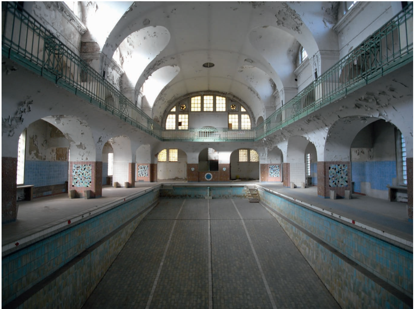
Abb. 2: Stadtbad Gotha, Alte Halle vor der Sanierung, 2007
