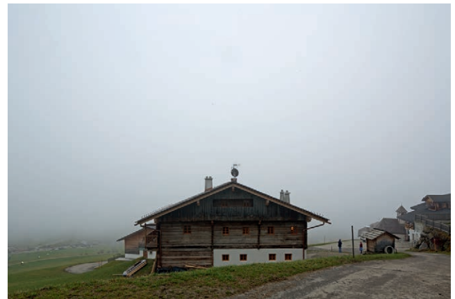
Abb. 6: Südtirol, Veidlerhof St. Magdalena Gsies nach dem Wiederaufbau
