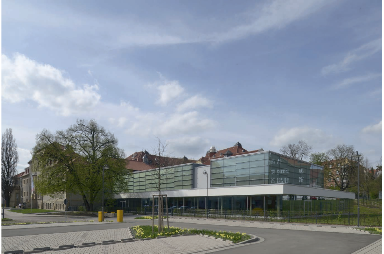
Abb. 4: Stadtbad Gotha, Neue Halle Südansicht, 2014
