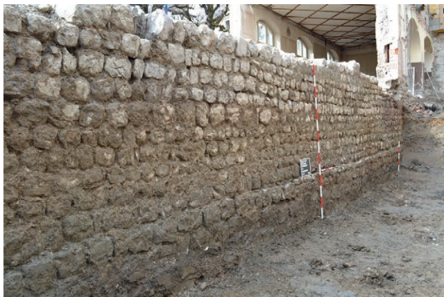
Abb. 5: Stadtmauer nach Freilegung, Sternarkaden, Salzburg, 2010
