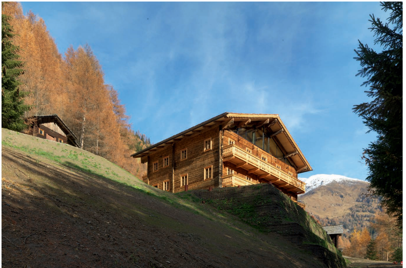
Abb. 11: Osttirol, Rainerhof in Kals nach der Renovierung
