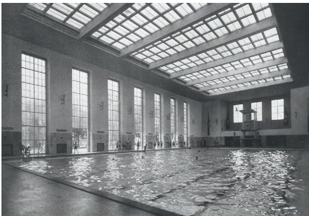
Abb. 6: Schwimmhalle Finckensteinallee Berlin Lichterfelde, 1940
