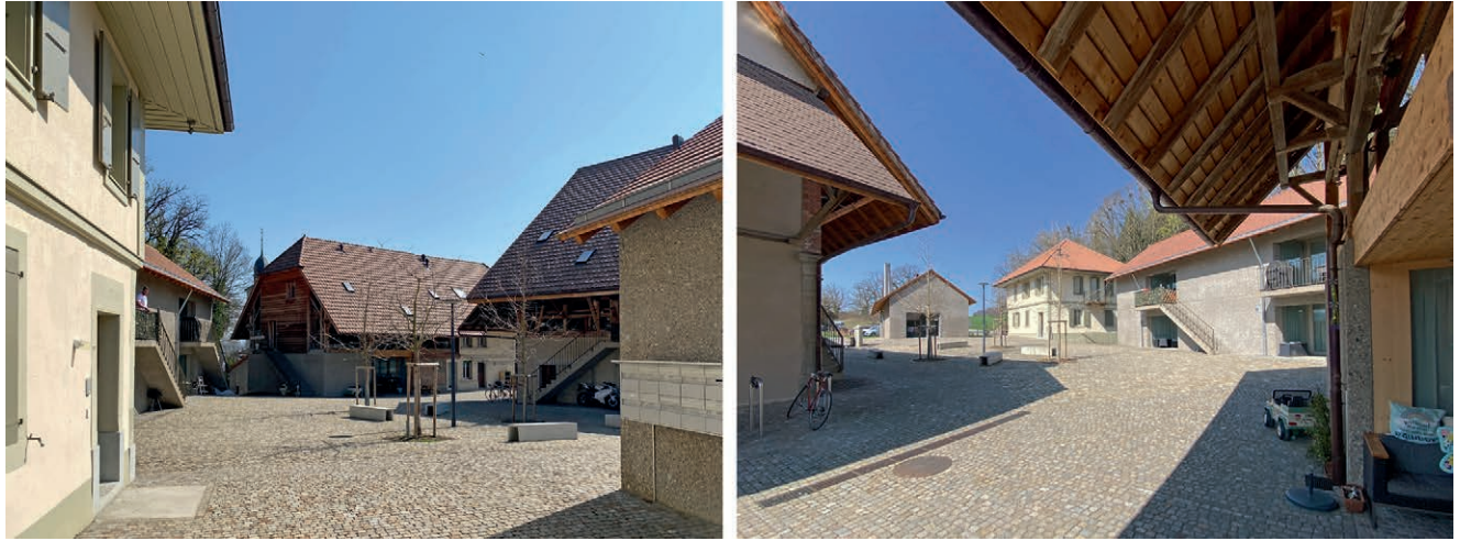
Abb. 7: Cressier, Kanton Fribourg, Schweiz, Dorfvitalisierung, links das Ensemble von Westen, rechts der hofartige Aussenraum, Aufnahmen 2017
