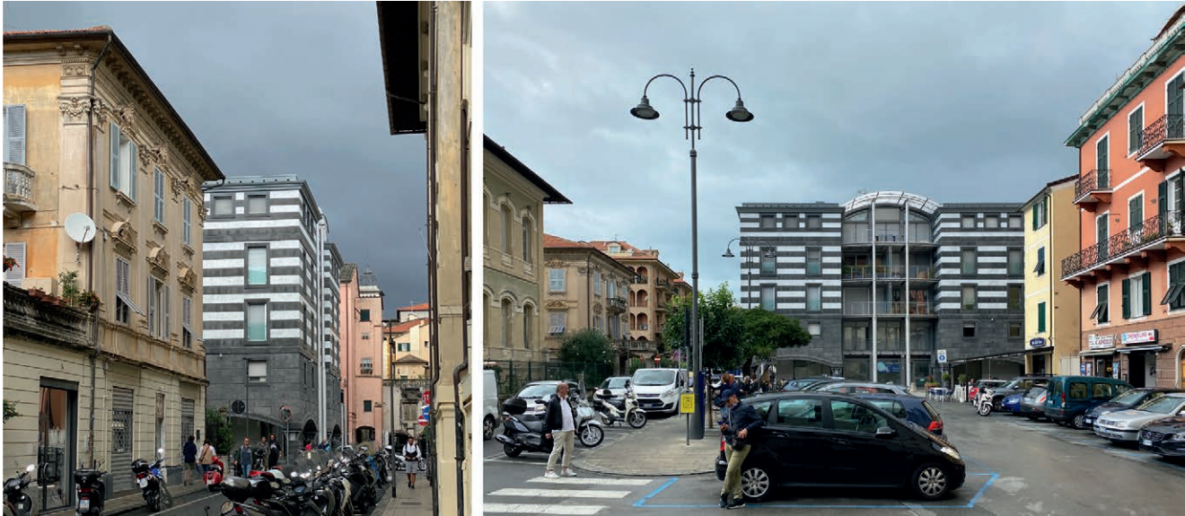
Abb. 6: Chiavari, Region Ligurien, Italien, Palazzo ex „Cinema Nuovo“, links von der Via Davide Gagliardo, rechts von der Piazza della Torre, Aufnahmen 2021
