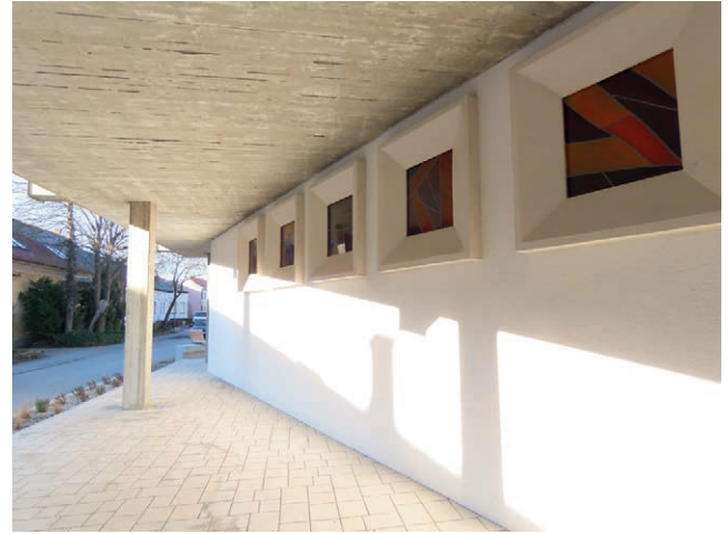
Abb. 3: Filialkirche Aderklaa, betonsichtige Vordachgestaltung
