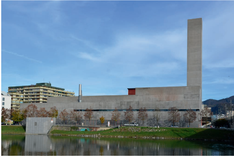
Abb. 4: Heizkraftwerk Mitte, Salzburg Heizkraftwerk Mitte, Salzburg, Marie-Claude Bétrix & Eraldo Consolascio, 1997–2002
