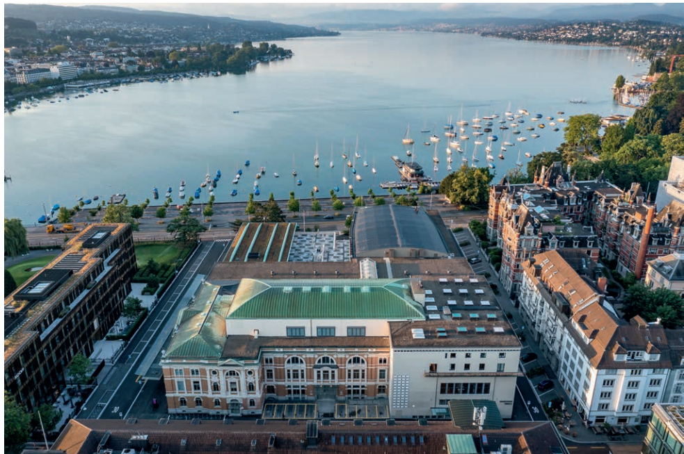
Abb. 9: Stadt Zürich, Kon- gresshaus und Tonhalle mit Bauteilen von 1895, 1939 und 2021; dazwischen liegend die wiedererlangte, zum See orientierte Terrasse
