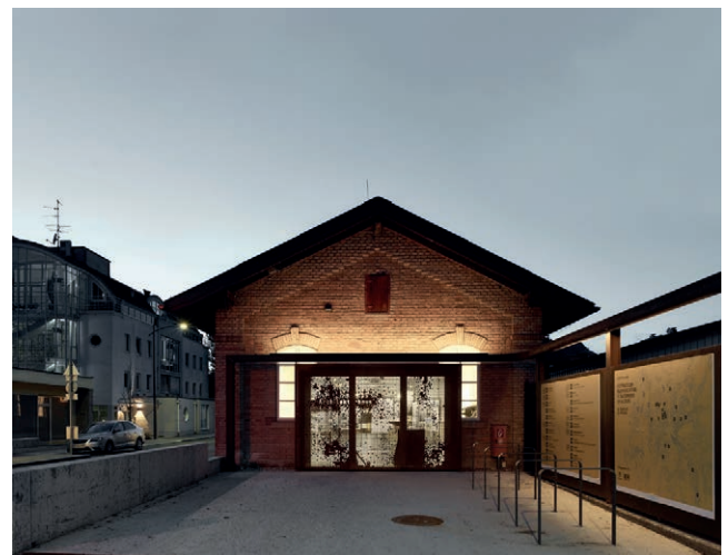
Abb. 13: Adaptierung eines Pferdestalles der einstigen Riedenburgkaserne für eine Kultureinrichtung, Architekturhaus Salzburg, Planung: Vorstand Initiative Architektur, 2016–2018
