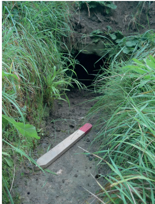
Abb. 3: Angeschnittene Wasserleitung mit horizontaler Abdeckung, Rechnitz
