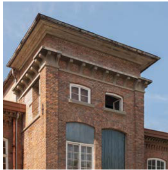
Nordfassade, Anbau Nordosten, mit historischen Fenstern
