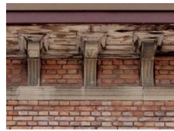
Detail an der Nordfassade
