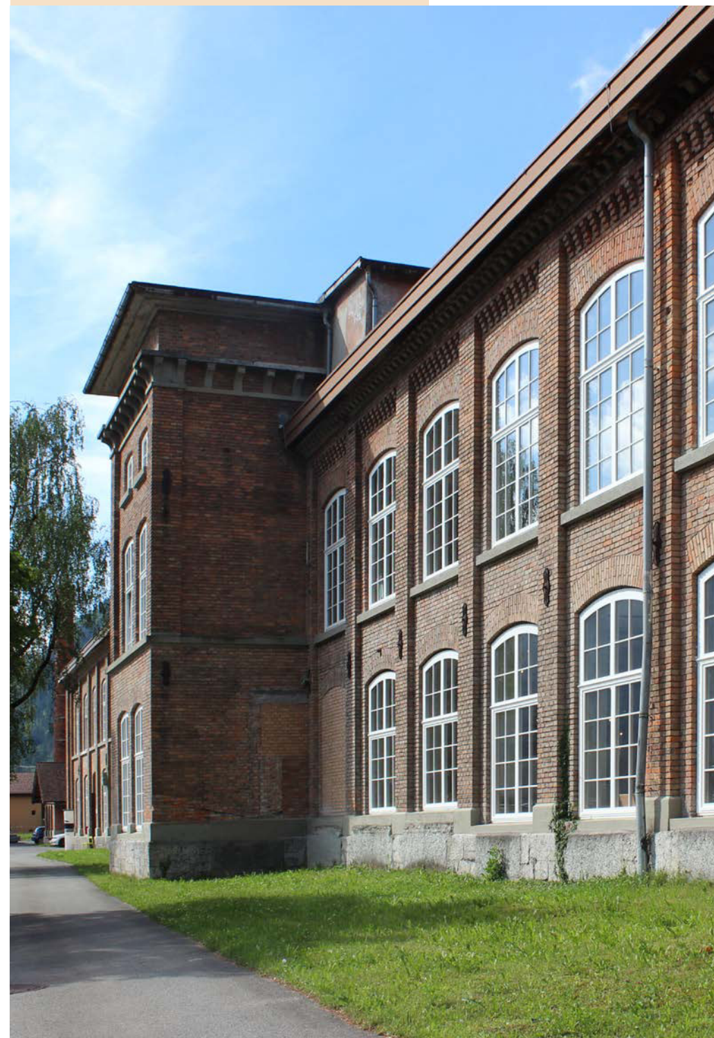
Nordostfassade mit neuen Fenstern
