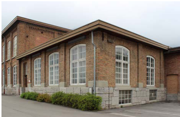
Büro der Betriebsleitung von Norden
