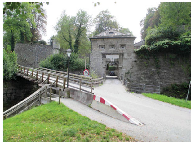
111. Salzburg, Monikapforte, Blick auf den äußeren Torbau von Norden, am linken Bildrand eine Polygonalbastion des inneren Mauerrings, im Vordergrund links ein Brückenprovisorium
