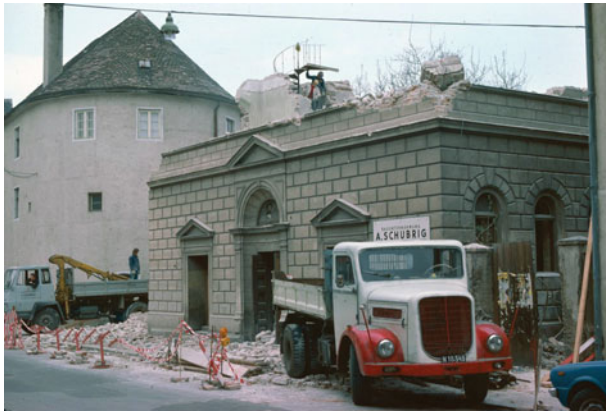
78a. Krems, NÖ, Dinstlstraße, Synagoge, Bestandsaufnahme der Abbrucharbeiten am 12. März 1978
