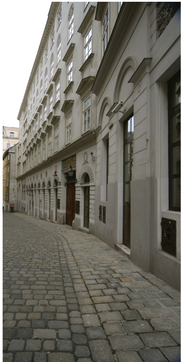
70. Wien 1, Seitenstettengasse 4, straßenseitige Ansicht des Stadttempels, Aufnahme 2010
