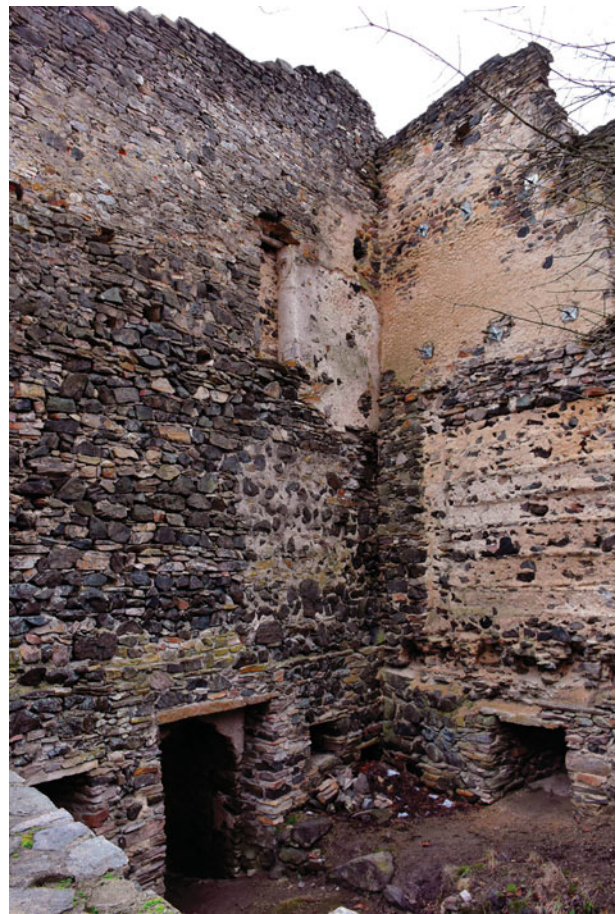
53. Krug, NÖ, Burgruine Schauenstein, sichtbare Mörtelabdrücke der Holzelemente einer gotischen Stube, Aufnahme 2018
