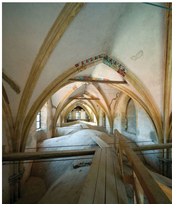
27. Gaming, NÖ, Kartäuserkirche, Zwischengeschoss unter bauzeitlichem Gewölbe, Aufnahme 2016
