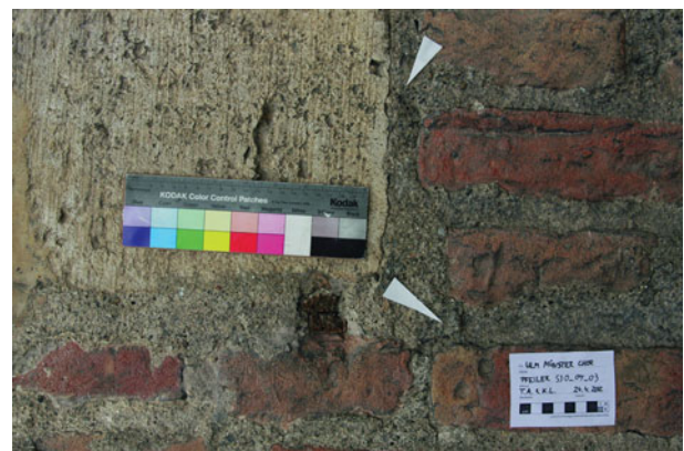
14. Ulm, Deutschland, Münster, Chor, Pfeiler Süd 3, Westseite, Lage 8, Befund 1. Bauforschung erfasst am Objekt Bau- und Bauabschnittsfugen und klärt die relative Abfolge der einzelnen Konstruktionseinheiten. Die breiten Mörtelfugen haben zu plastischen Verformungen der Bauteile während des Bauprozesses geführt.
