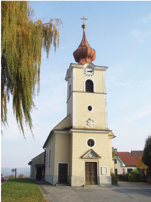
81. Reichersdorf, NÖ, Filialkirche, Außenansicht
