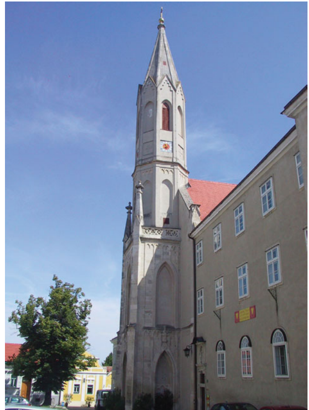
87. Eggenburg, NÖ, Redemptoristenkirche, Außenansicht
