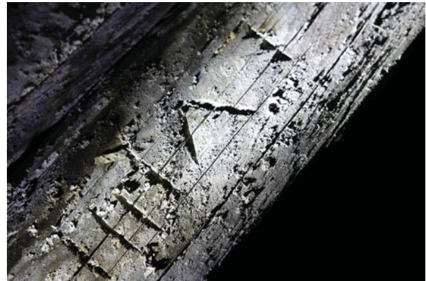
69. Das Abbundzeichen mit der römischen VIII (auf dem Kopf stehend) und drei Fähnchenausstichen darüber. Das Zeichen bedeutet „9. Sparren im 3. Vollgespärre“
