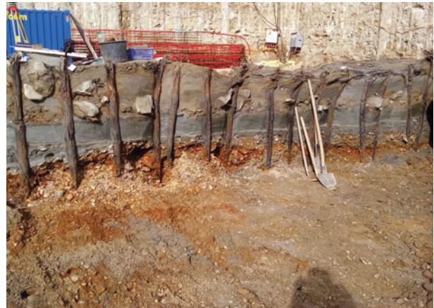
43. Stein an der Donau, NÖ, mittelalterliche Uferbefestigung, Aufnahme 2017
