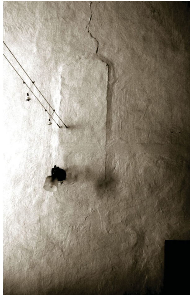
31. Aggsbach, NÖ, Kartause, Refektoriumstrakt, vermauerte Einstiegs Luke in den Dachboden von der Empore der Kirche, Aufnahme 2005
