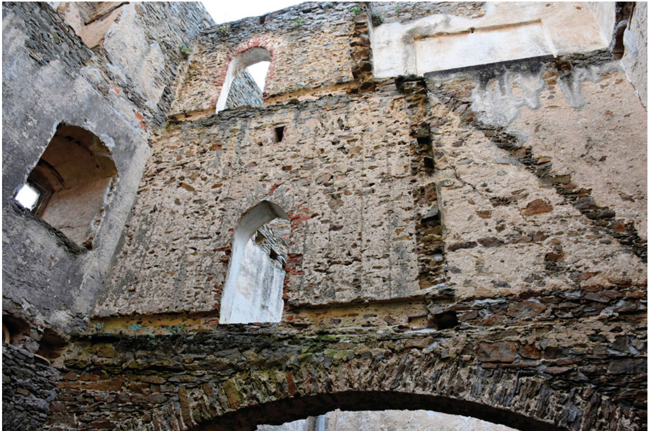
52. Aggstein, NÖ, Burgruine, sichtbare Mörtelabdrücke der Holzelemente einer gotischen Stube, Aufnahme 2018
