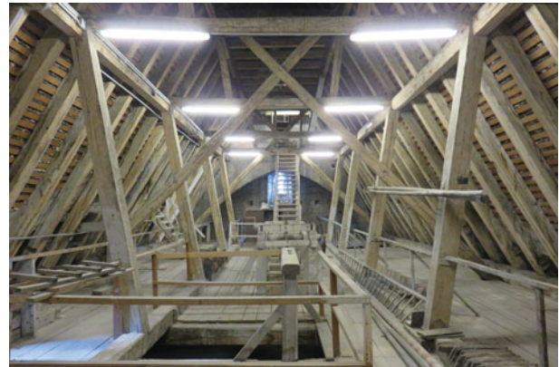
65. Wien 1, Malteserkirche, Dachwerk 1312 mit Bockgerüst in zwei Geschossen und Kreuzstreben
