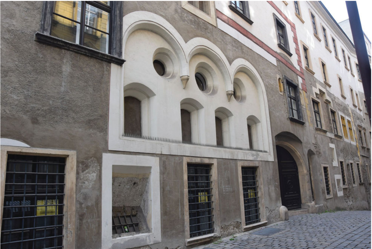
46. Wien 1, Griechengasse 4, Freilegung einer gotischen Fenstergruppe, Aufnahme 2016
