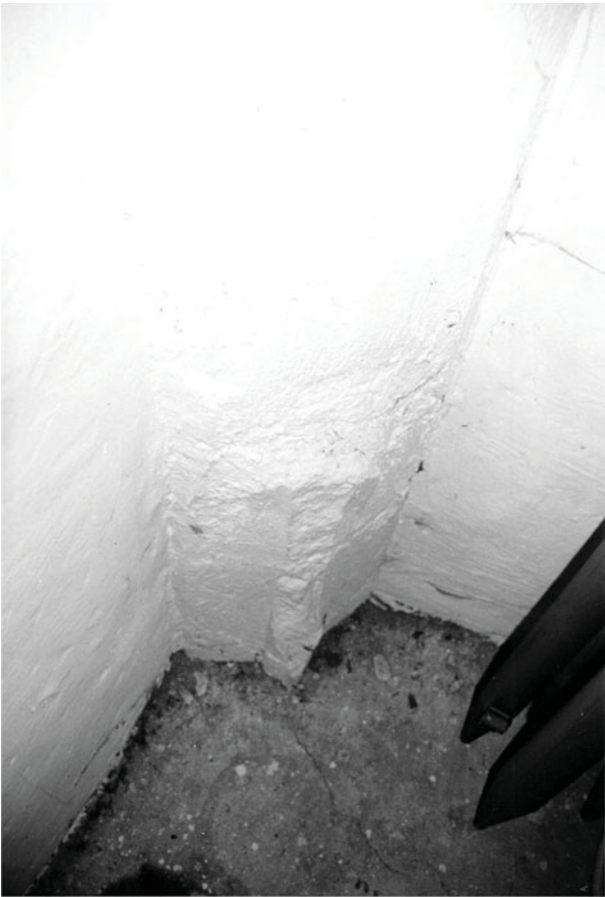
30. Aggsbach, NÖ, Kartause, Refektoriumstrakt, Pfeilerwandvorlage im Erdgeschoss, Aufnahme 2005
