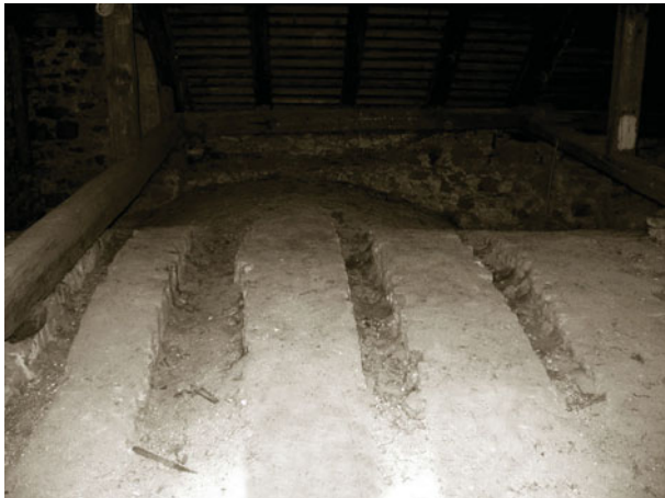
33. Aggsbach, NÖ, Kartause, Refektoriumstrakt, Dachboden, Aussparungen bzw. Negativabdruck der ehemaligen Bundträme des historischen Dachstuhls im Gewölberücken, Aufnahme 2005
