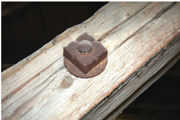
68. Wien 1, Akademie der Wissenschaften, Alte Aula, mit Bolzen und verzierter Vierkantschraube verspannte zweiteilige Sprengstrebe von 1820
