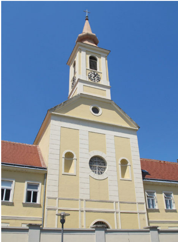
86. Krems-Stein, NÖ, ehem. Redemptoristinnenkirche, Außenansicht
