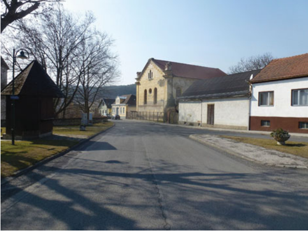
73. Kobersdorf, Bgld, renovierungsbedürftige Synagoge, Aufnahme 2012
