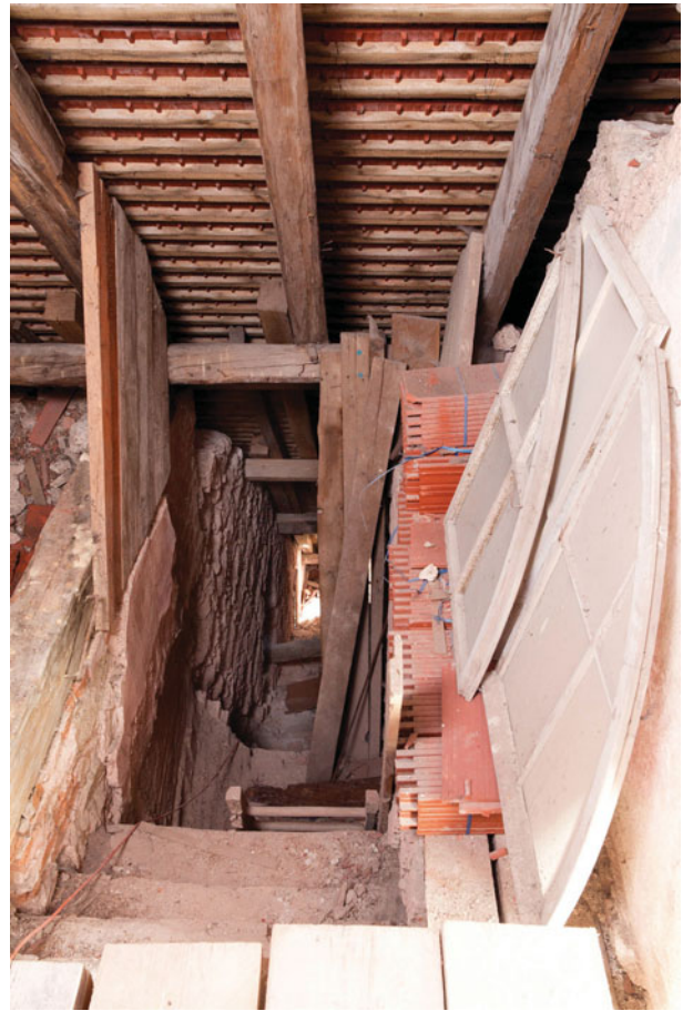
28. Gaming, NÖ, Kartäuserkirche, Dachboden der epistelseitigen Doppelannexkapelle, Fragment eines Stiegenaufgangs, Aufnahme 2016
