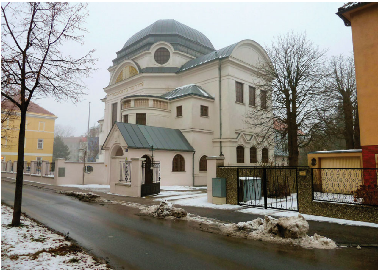
72. St. Pölten, NÖ, renovierte Synagoge, Aufnahme 2010
