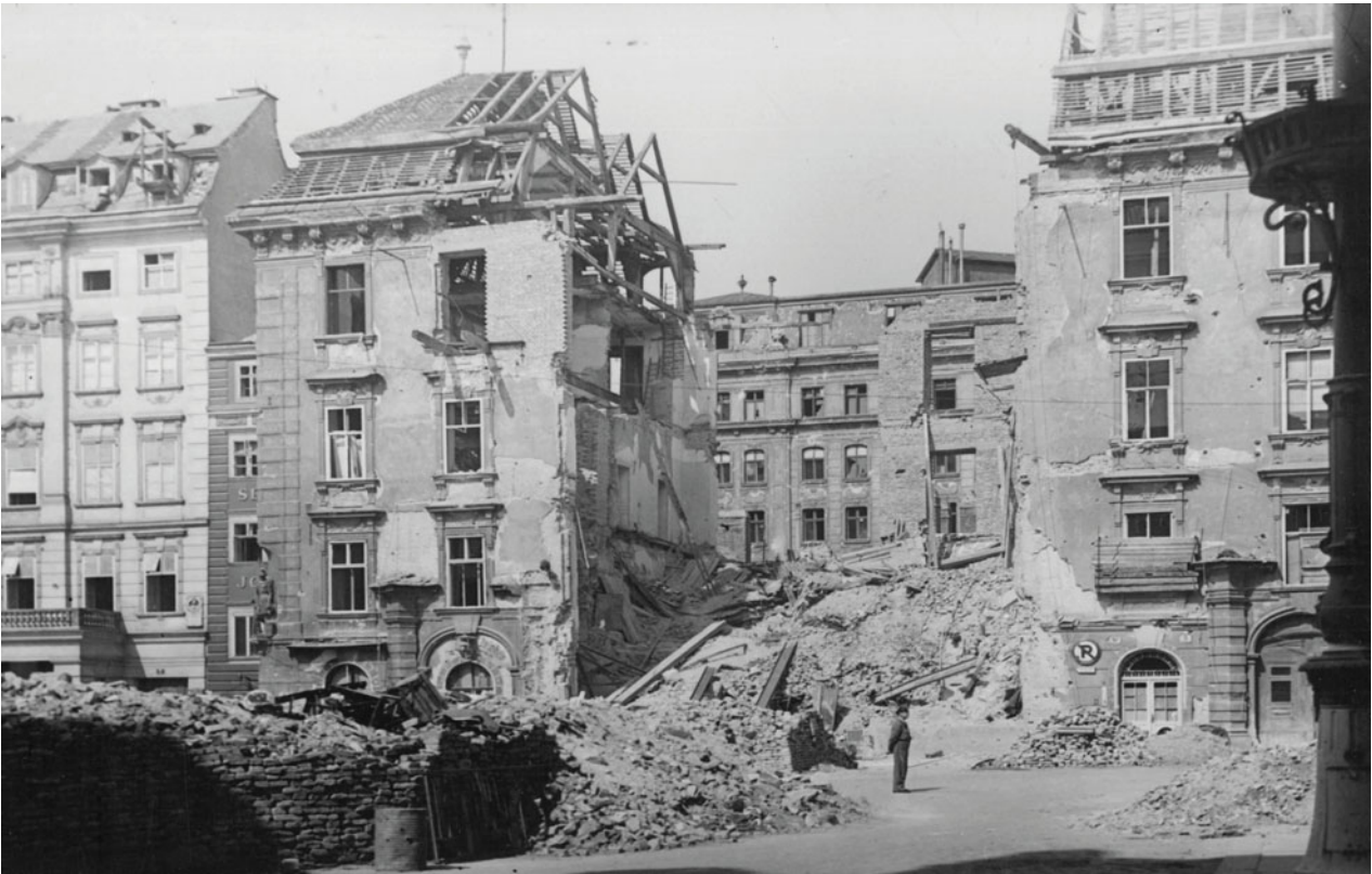
66. Wien 1, Am Hof 9, barocke Dachkonstruktion in Form eines Mansarddaches mit Firstgraben
