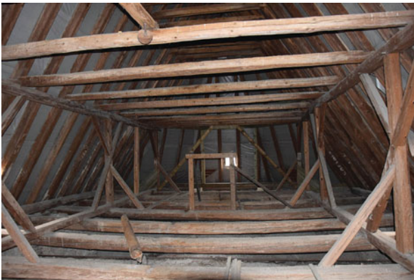
41. Ebenfurth, NÖ, Pfarrkirche, Einblick in den Chordachstuhl, Aufnahme 2016
