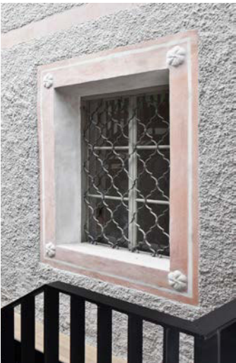
Fensterdetail an der Südseite
