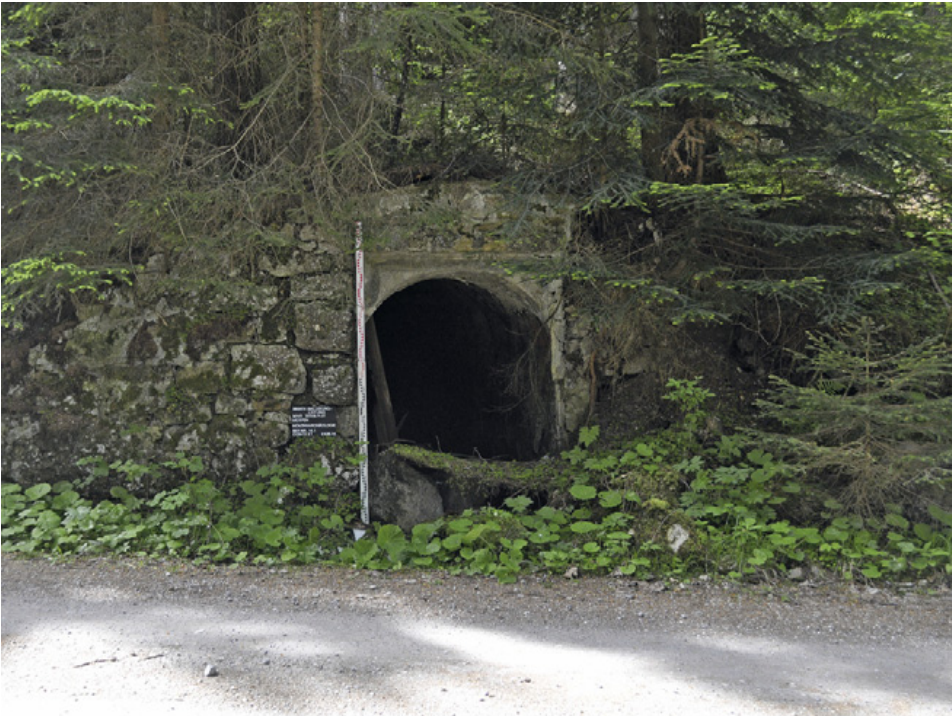
Abb. 74: Reitsam (Mnr. 55508.14.01). »Bergbau Schäferötz«. Stollenmundloch des Anton-Stollens.
