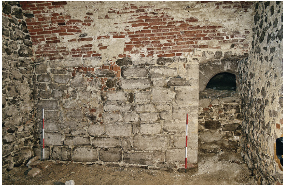
Abb. 3: Burg Güssing. UG1. Nordmauer mit fragmentiert erhaltener Türöffnung und vermauertem Fenster.
