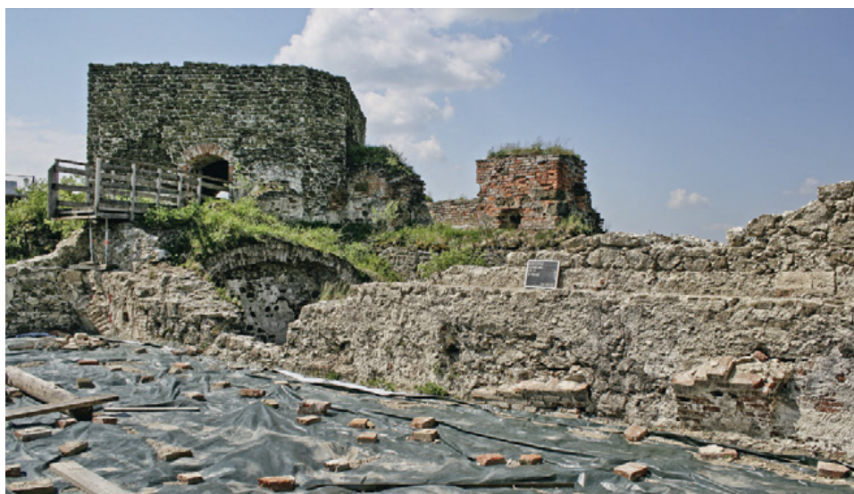
Abb. 10: Burg Güssing. EG5. Westmauer mit Geschoßauflager und jüngerem Gewölbeansatz. Im Hintergrund die Nordseite des Ujlakiturms.
