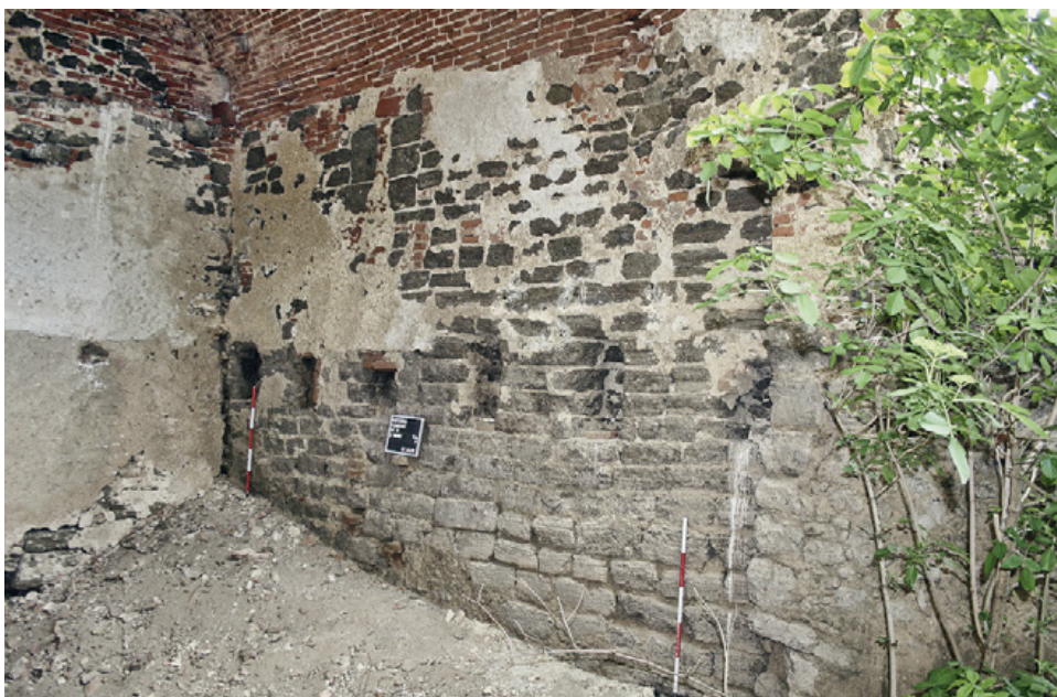
Abb. 5: Burg Güssing, UG10. Südmauer mit verfülltem Scharfenfenster.
