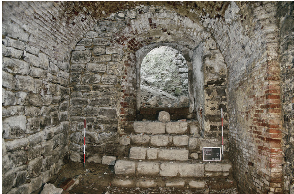
Abb. 4: Burg Güssing. UG2. Ostmauer mit sekundär vergrößerter Türöffnung.
