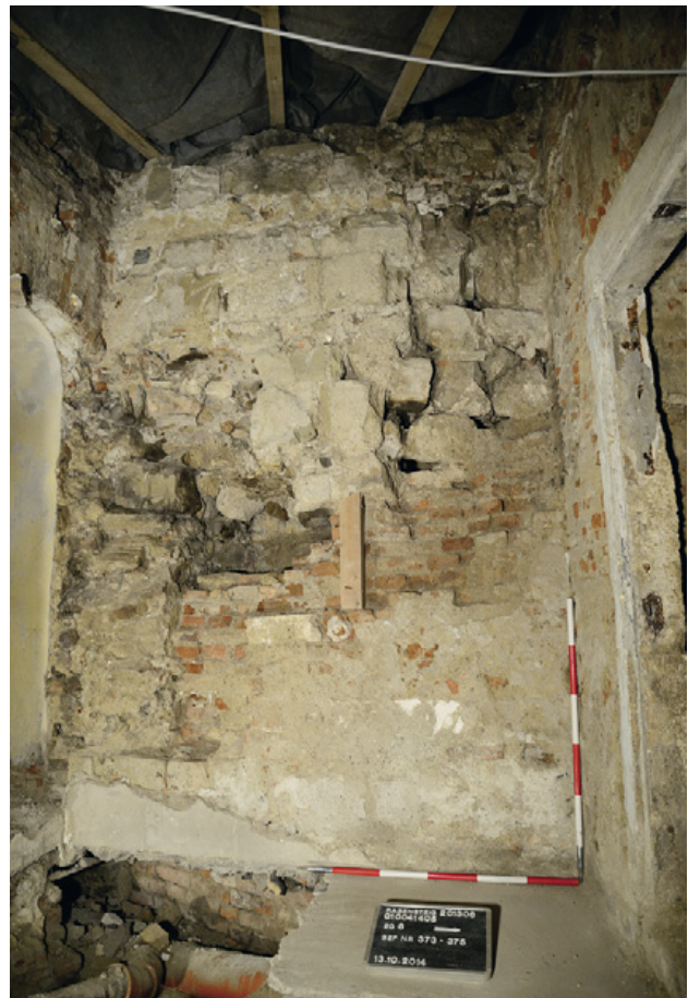
Abb. 118: Innere Stadt (Mnr. 01004.14.05). An den L ss gestellte Hangbefestigungsmauer des 12. Jahrhunderts (Blick nach Westen).
