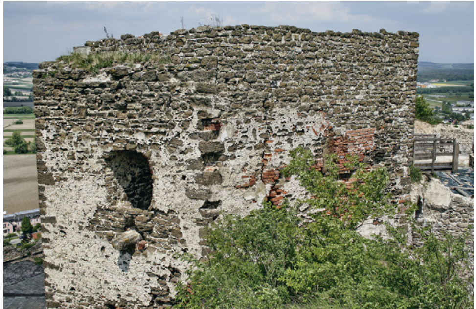
Abb. 11: Burg Güssing. Südseite des Ujlakiturms mit Küchenausgussrinne unter dem Fenster.
