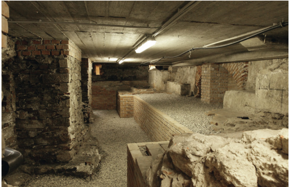
Abb. 27: St. Pölten (Mnr. 19544.13.07, 19544.14.06). Blick in den Kapitelsaal nach Abschluss der Arbeiten.
