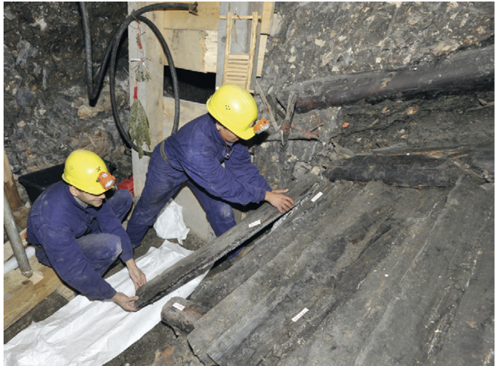
Abb. 66: Hallstatt (Mnr. 42007.13.01). Abbau der ersten Teile der bronzezeitlichen Stiege.
