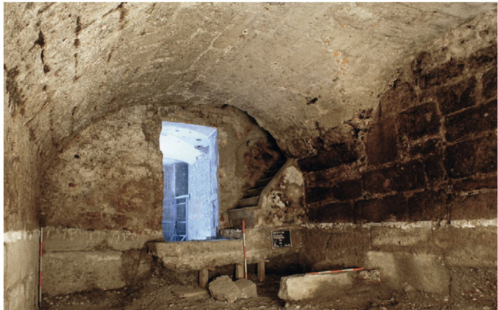
Abb. 76: Salzburg (Mnr. 56537.14.09). Getreidegasse Nr. 34. Spätmittelalterlich-frühneuzeitlicher Keller aus Konglomeratquadern.
