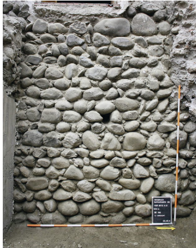
Abb. 94: Innsbruck (Mnr. 8113.14.01). Fundamentbereich der romanischen Stadtmauer (Ostansicht).
