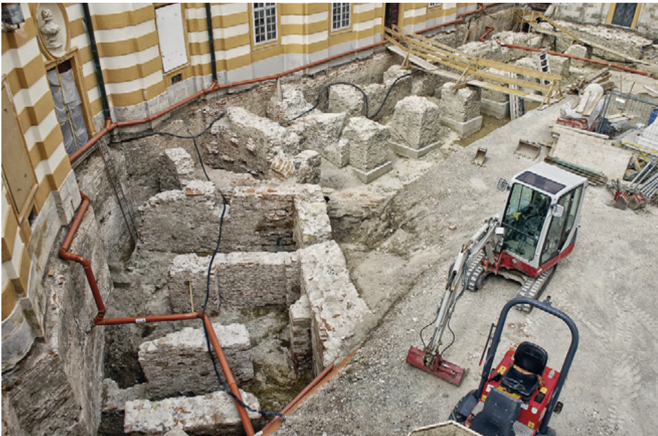
Abb. 7: Stift Melk (NÖ). Neuzzeitliche Baureste im Bereich der Altane im Kolomanihof.
