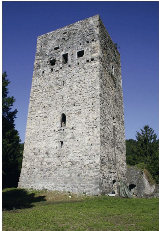
Abb. 110: Tosters (Mnr. 92125.14.01). Bergfried der Burg Tosters mit Hochein- gang in der Ostfassade und ebenerdigem Durchbruch an der Nordseite (Blick von Osten).
