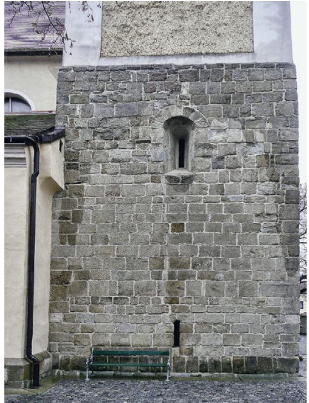
Abb. 8: Tulln, Pfarrkirche. Nordfassade des nördlichen Westturms.
