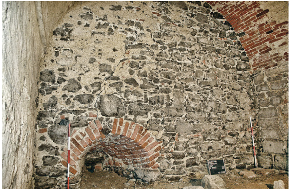
Abb. 12: Burg Güssing. UG1. Westmauer mit Scharfenfenster; die linke Fensterlaibung ist unverändert, während die rechte in einer jüngeren Phase erweitert wurde und zusammen mit der aus Ziegeln errichteten Fensteroberkante entstanden ist.
