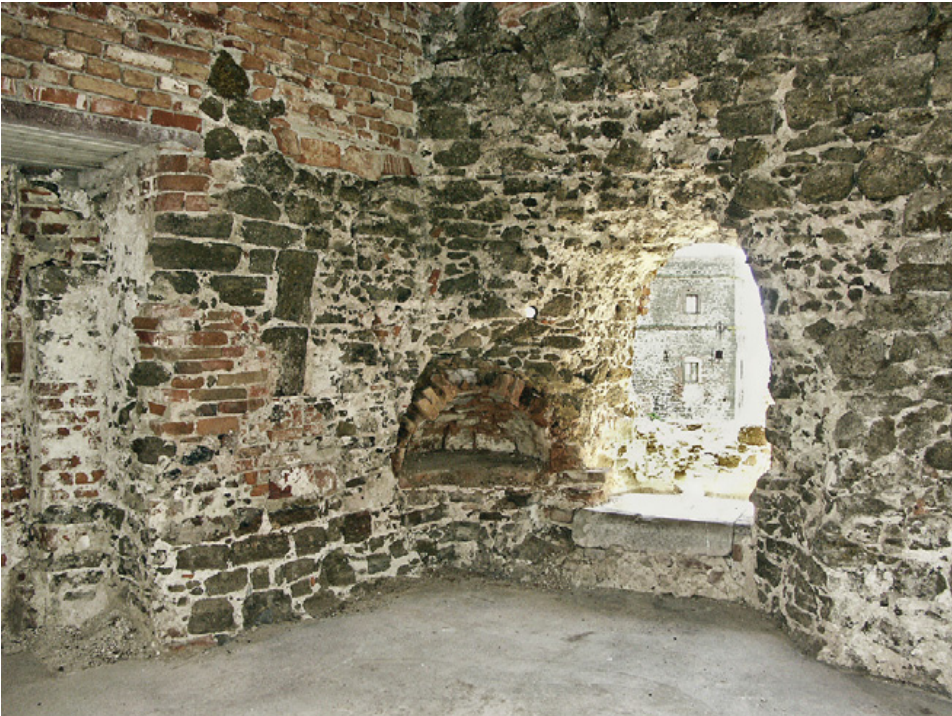
Abb. 13: Burg Güssing. 2. Obergeschoß des Ujlakiturms. Küche mit Backofen in der Südostecke.
