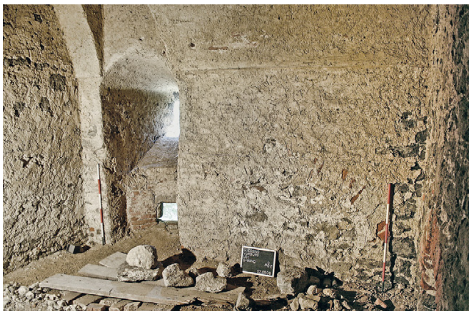
Abb. 15: Burg Güssing, UG1. Süd-mauer mit primärem, vermauertem Schartenfenster rechts und sekundärem Schartenfenster (mit zwei Öffnungen) links.
