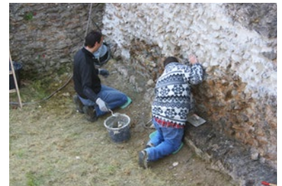
Neuverfugung des antiken Mauerwerks
