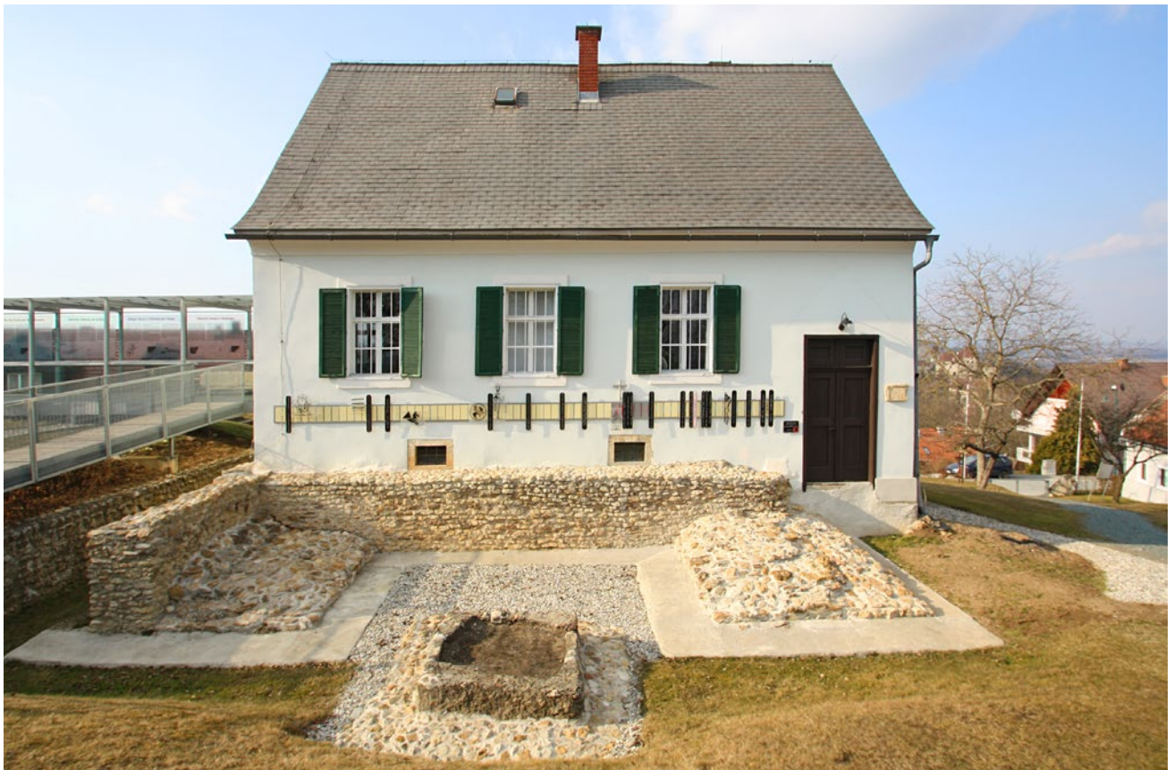
Tempelfront und Altar nach der Sanierung
