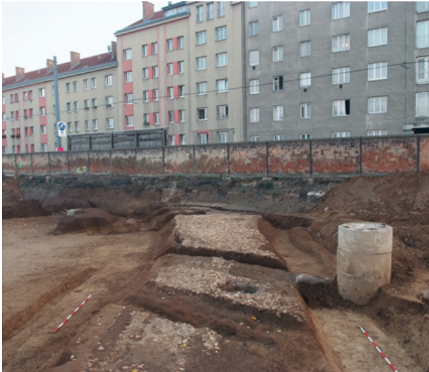
Abb. 137: Favoriten, Gudrunstraße. Neuzeitliche Straßenschotterung mit angrenzenden Gräben nahe der Einmündung der alten »Heugasse« in den »Simmeringer Weg« (Ansicht von Norden).
