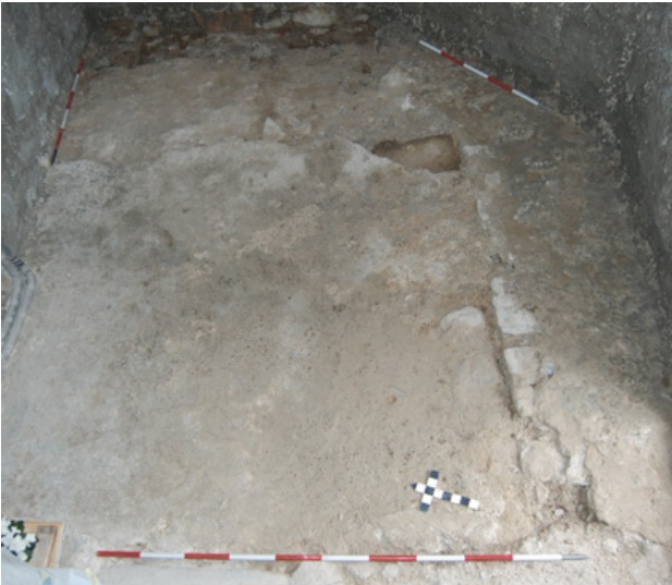
Abb. 43: St. Veit an der Gölßen. Vermutlich romanische Sakristeimauer in der Pfarrkirche Hl. Veit.
