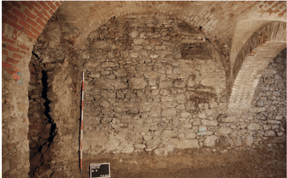
Abb. 35: Nußdorf an der Traisen. Spätmittelalterliches Mauerwerk im Keller des untersuchten Gebäudes.
