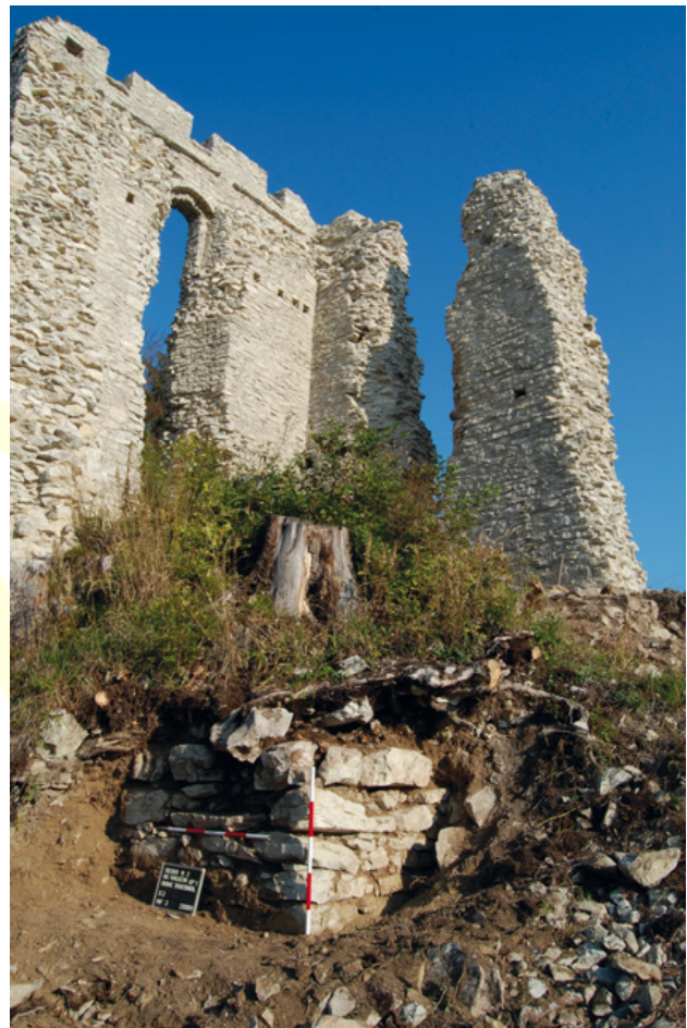
Abb. 87: Hallein, Ruine Thürndl. Freigelegte Südwestecke des Turms.
