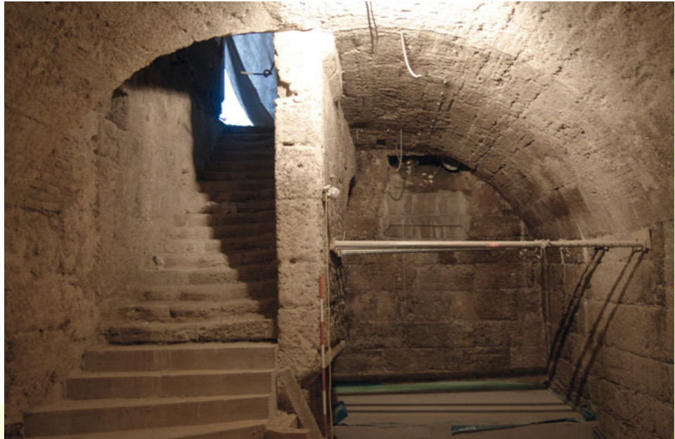
Abb. 92: Salzburg, Gablerbräu. Spätmittelalterlicher Gewölbekeller aus Konglomeratblöcken.
