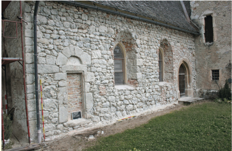
Abb. 123: Stans. Südfassade der Lindenkirche in St. Georgenberg mit romanischem Portal.
