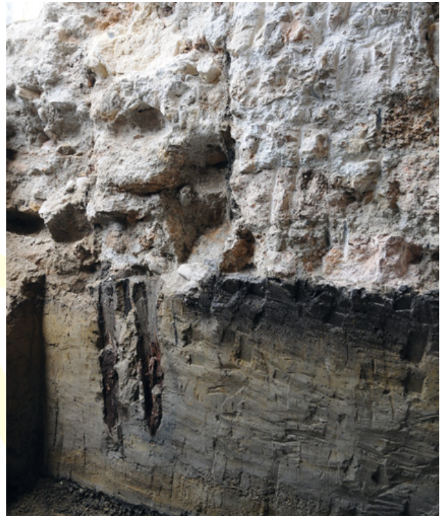
Abb. 51: Wiener Neustadt, Dompropstei. Südlabung des Mauerdurchbruchs mit Pfahlfundierung der neuzeitlichen Quadermauer.
