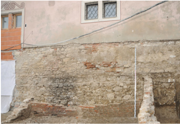
Abb. 17: Gumpoldskirchen. Ostmauer des einstigen Presskellers der Grangie in Thallern mit sekundärem, eingetieftem Anbau.
