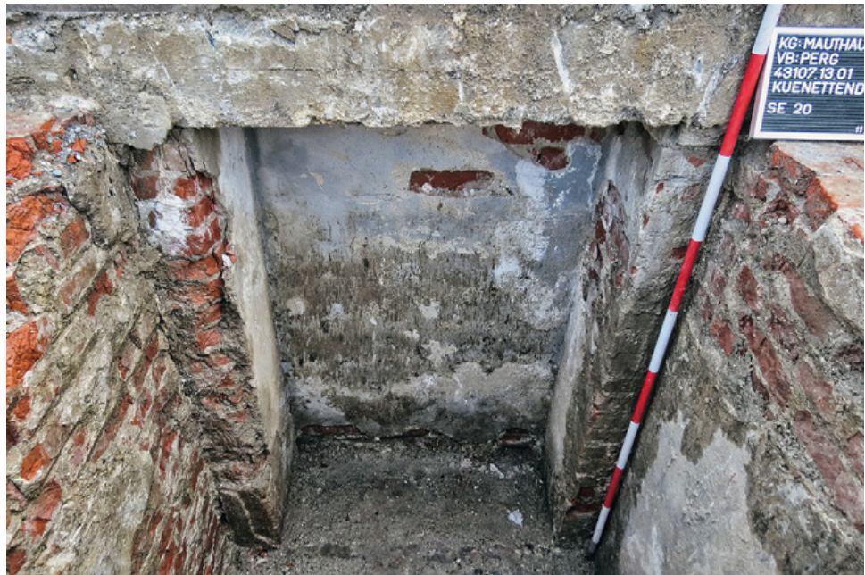
Abb. 74: Mauthausen (Mnr. 43107.13.01). Vermauerte ›Türnische‹ (SE 20) vor der Gaskammer des Konzentrationslagers.
