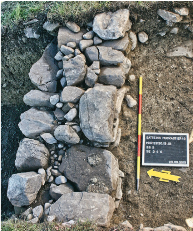
Abb. 136: Satteins (Mnr. 92120.13.01). Abrissoberkante der vermutlich römisch-zeitlichen Befestigungsmauer (SE 4).
