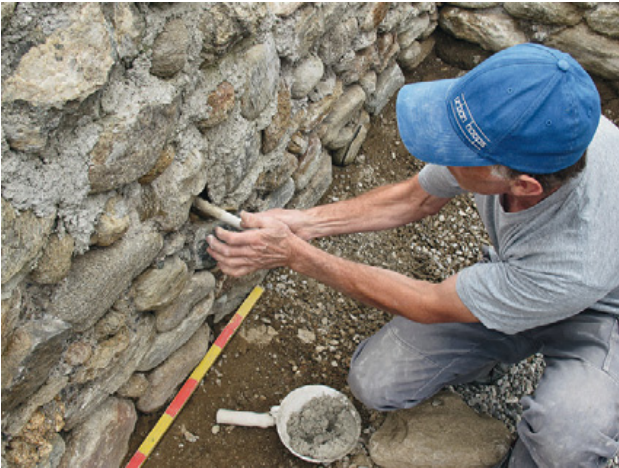
Abb. 16: Dölsach (Tir.), archäologischer Park Aguntum . Restauratorische Probearbeiten am Forum.
