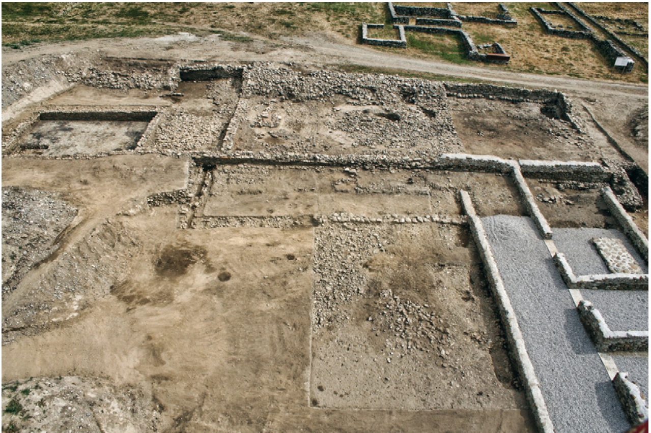
Abb. 118: Stribach (Mnr. 85034.13.02). Freigelegte Befunde im Nordflügel des Forums von Aguntum (Blick von Süden).
