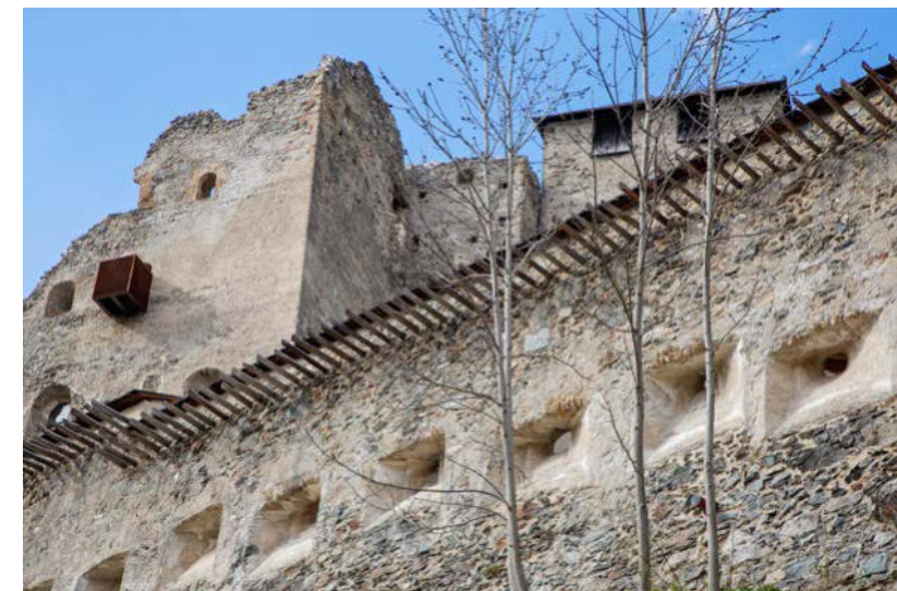
Ringmauer und Palas nach Restaurierung
