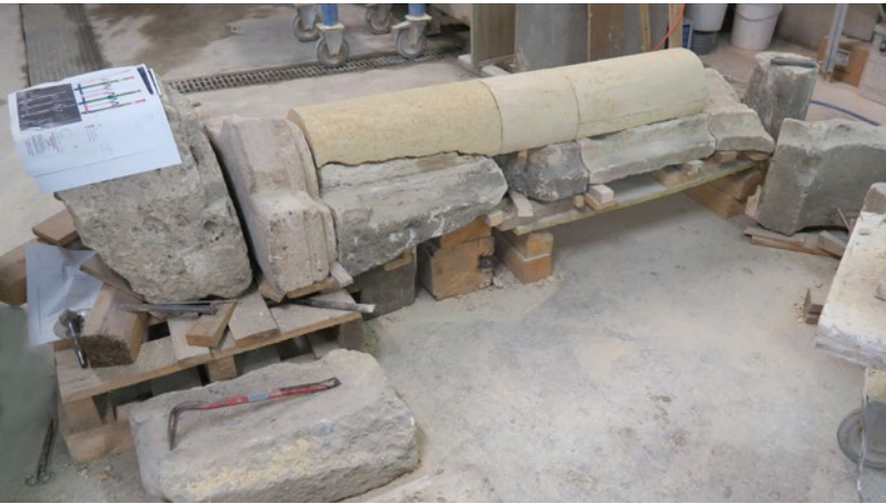
Abb. 5: Werksteingänzungen einer Wandlisenen
