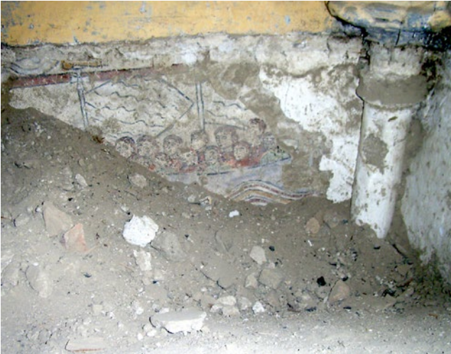
Abb. 3: Schon bei der Voruntersuchung 2005 fand sich im nordöstlichen Zwickel des renaissancezeitlichen Tonnengewölbes in der Torturmkapelle die früheste Wandmalerei der Gozzoburg aus dem zweiten Viertel des 13. Jahrhunderts: „Jonas und der Wal“
