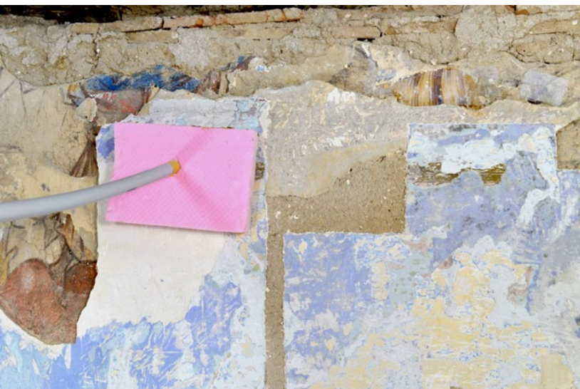
Abb. 10: Obwohl die Umbauphase 2006/07 konservatorisch begleitet wurde, waren Erschütterungen unvermeidbar. Vorfestigungen mit Pressstempeln stabilisierten den gotischen Bestand vor der Freilegung
