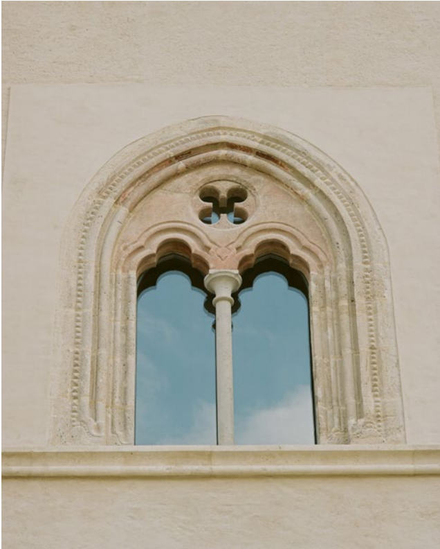
Abb. 13: Gozzoburg, Saalbau, Obergeschoß, Mittelfenster an der Nordfassade, um 1254
