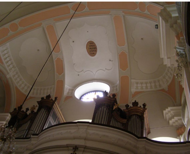
Abb. 9: Graz, Gewölbe über Orgelepore
