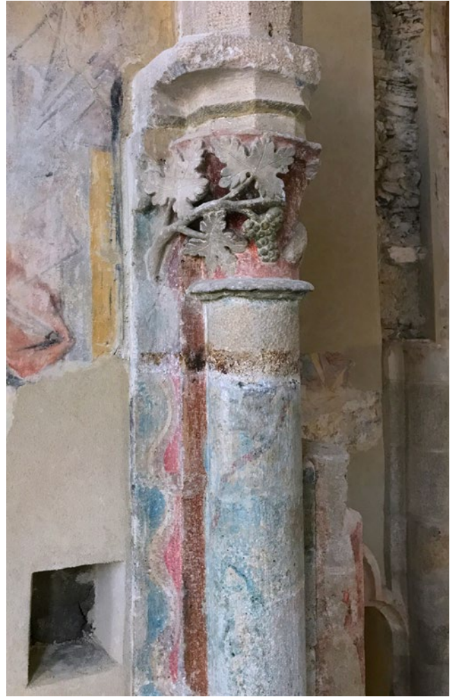
Abb. 15: Johannes- und Katharinenkapelle, Apsis, Blick gegen Südwesten, Blattkapitell mit bauzeitlicher Fassung und im 20. Jahrhundert abgearbeiteten Partien
