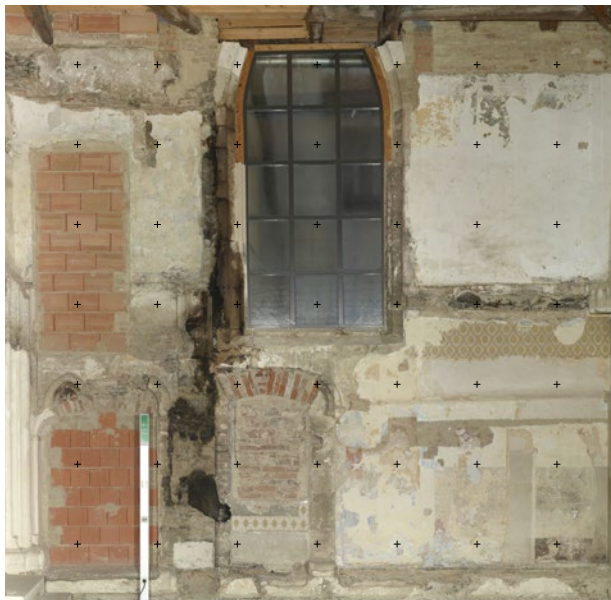
Abb. 2: Nordwand der Johannes- und Katharinenkapelle, Bildplan lt. Ö-NORM A 6250-2, Bildverzerrung in zwei Ebenen
