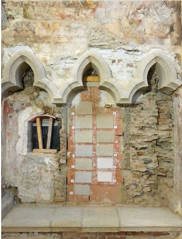
Abb. 13: Naturputzoberflächen haben einen hohen Stellenwert in der Präsentation der Raumschale, dafür wurden 15 Verputzmuster unterschiedlicher Zuschläge und Korngrößen sowie Oberflächenausbildung angelegt
