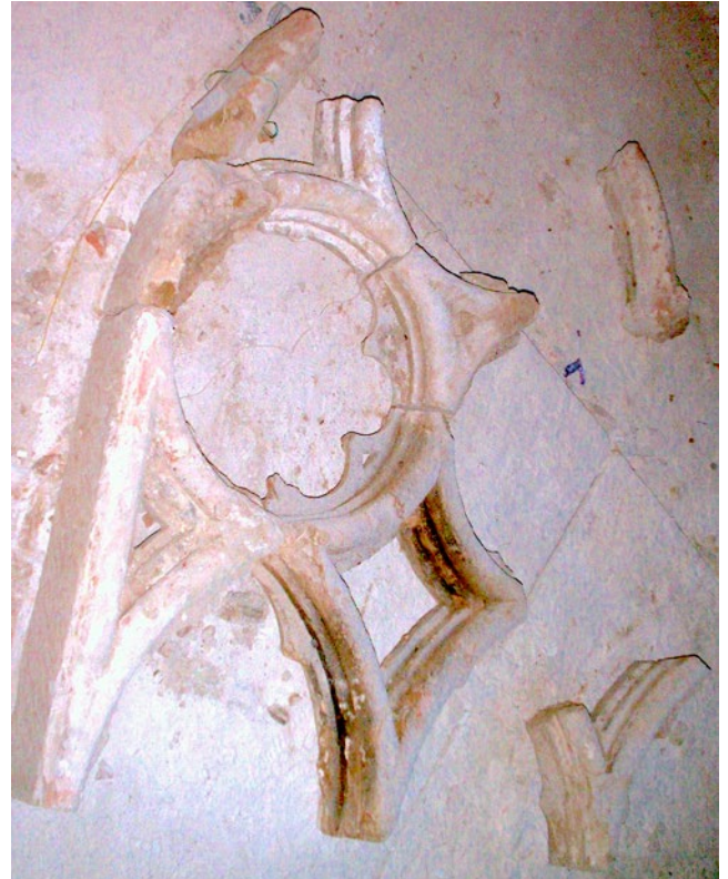
Abb. 2: Was an gotischer Baugliederung in der Umnutzung nicht mehr gebraucht wurde – Wandvorlagen, Rippen oder, wie hier, Maßwerk – fand später als Mauerstein in Zwischenwänden bzw. Schüttungen Verwendung
