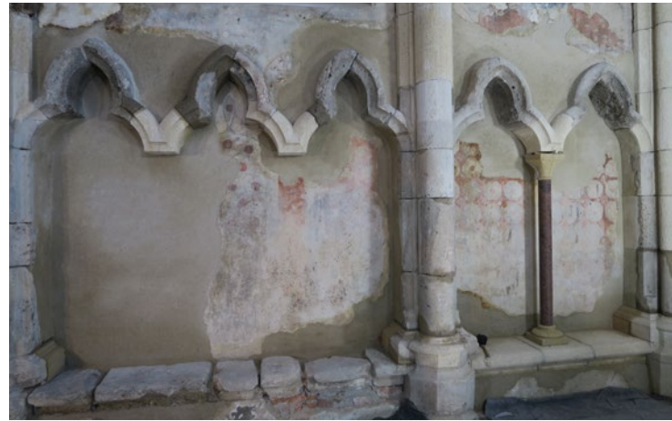
Abb. 6: Gesamtansicht der restaurierten Johannes- und Katharinenkapelle mit Blick Richtung Norden
