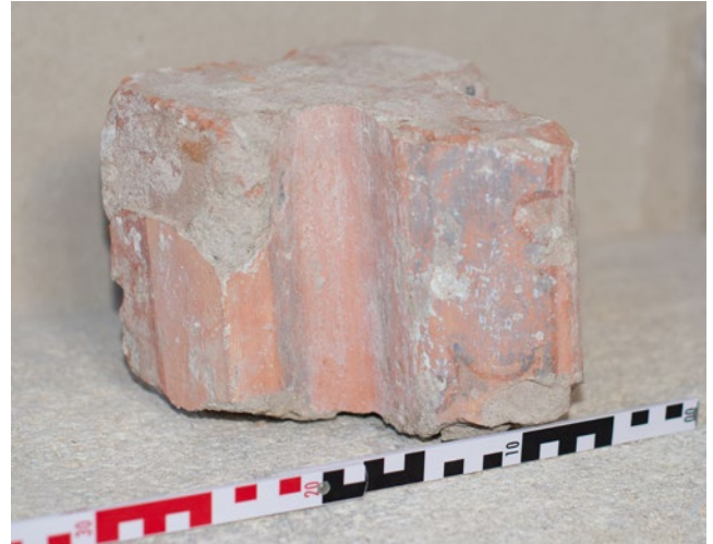
Abb. 17: Johannes- und Katharinenkapelle: Tonrippensegment, als Spolie geborgen aus einer der Zwischenmauern der Zeit um 1800
