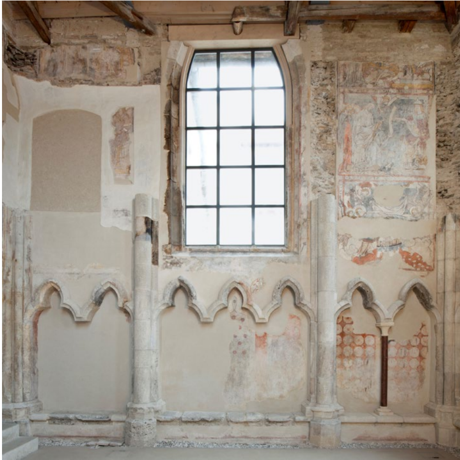
Abb. 5: Johannes- und Katharinenkapelle, Nordwand im Nachzustand
