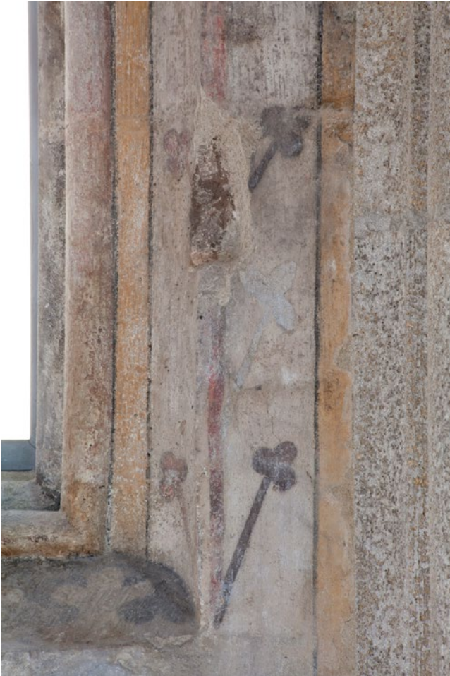
Abb. 107: Johannes- und Katharinenkapelle, Nordwand, Ast mit Blättern am Fenstergewände
