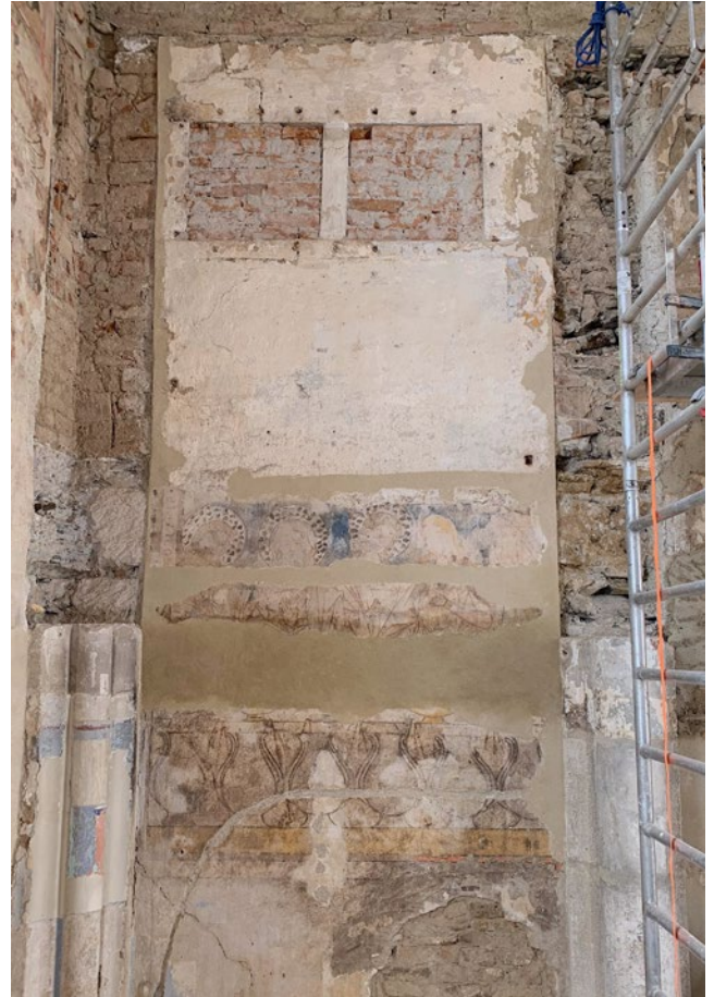
Abb. 8: 760 Jahre Genese als „ganze Geschichte“ erzählt: das im Barock eingefügte Oratorium mit den später wieder ausgemauerten quadratischen Öffnungen als Beispiel
