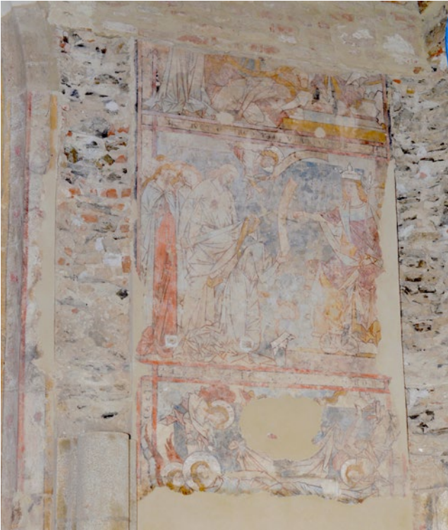
Abb. 11: Die verlorene Gewölbekonstruktion wird durch eine blockhafte Präsentation der Wandmalerei im Kontrast zum Bruchsteinmauerwerk wieder ablesbar
