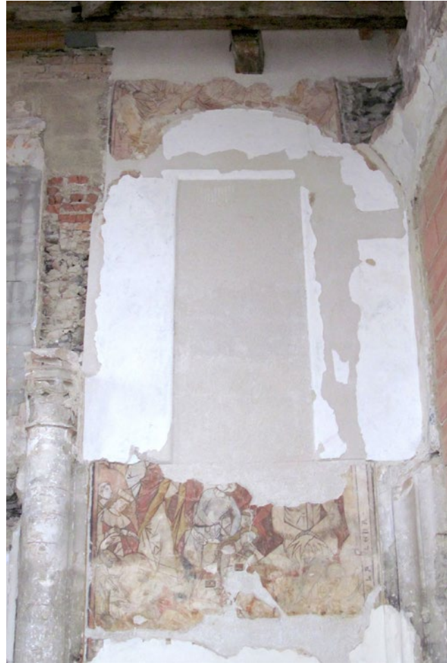
Abb. 7: Pflichtteil in der Konzeptentwicklung beim Umgang mit komplexen Baudenkmalern: die Anlage von Musterfläche, hier zur Abklärung der besten Freilegetechnik wie auch der Präsentationsoptionen
