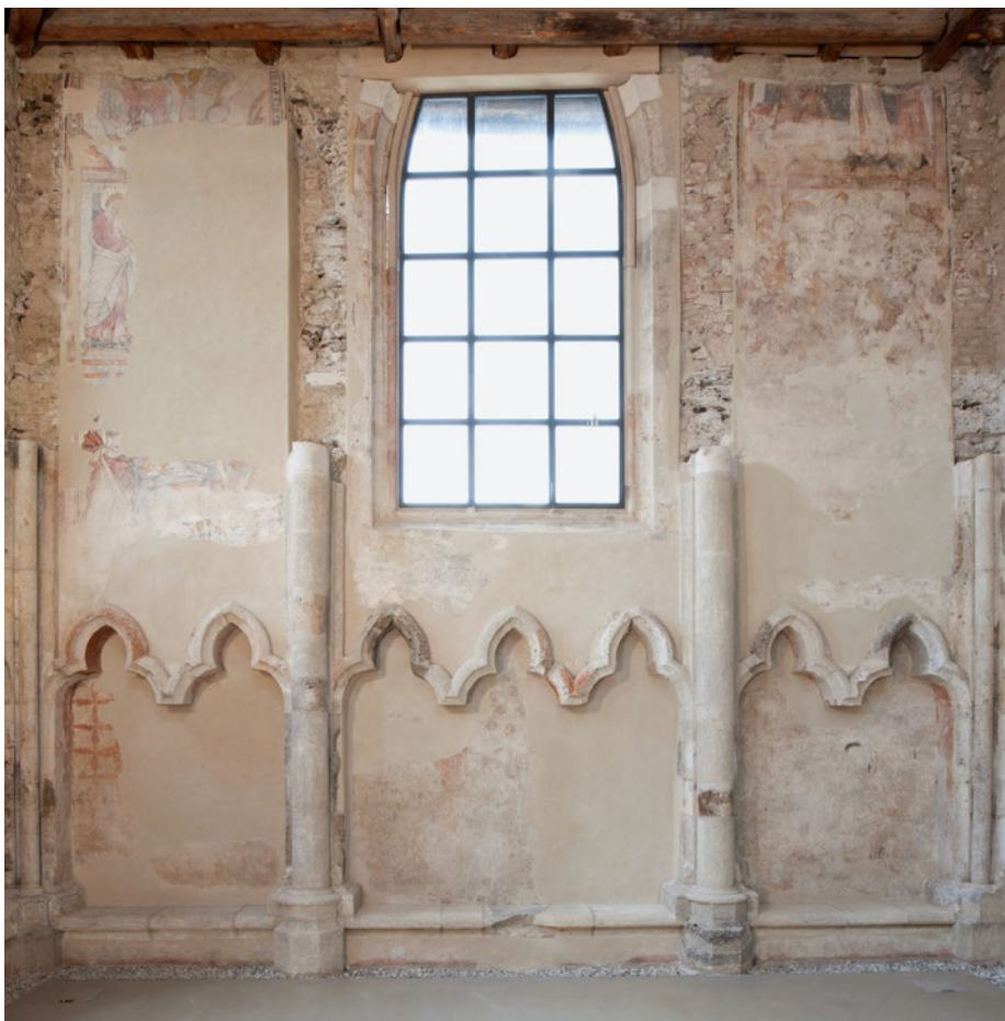
Abb. 6: Johannes- und Katharinenkapelle, Südwand im Nachzustand
