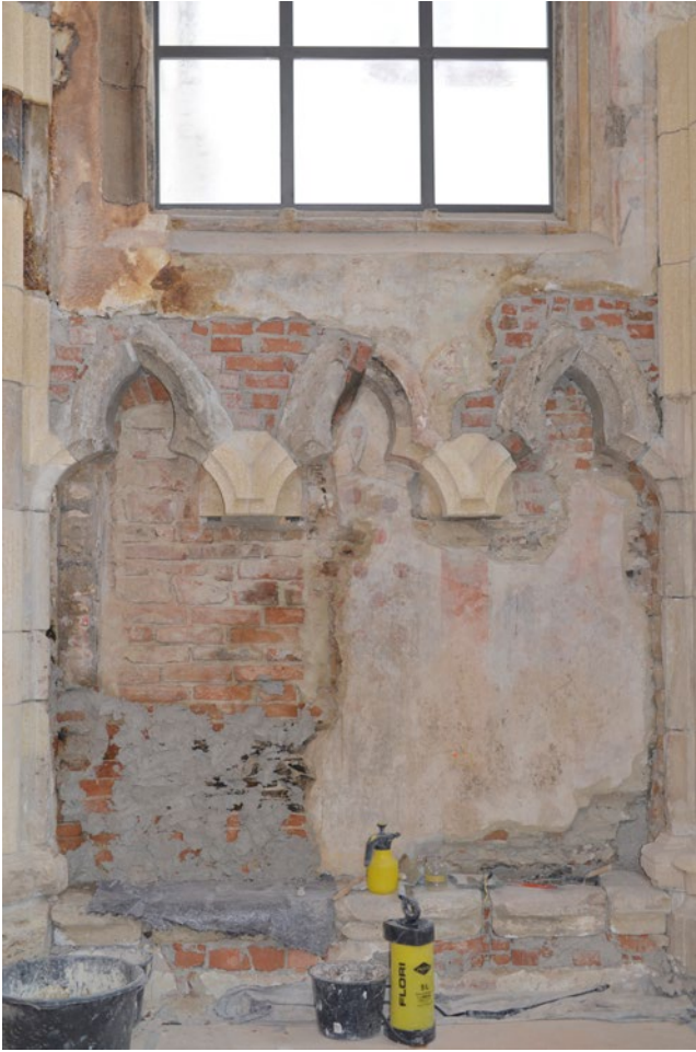
Abb. 17: Die reichen Werksteingliederungen sind ein Charakteristikum der Kapelle. Ihre Wiederherstellung stellt eine Kombination aus Werkstein, in situ Verbliebenem, Spolien und Rekonstruktionen dar
