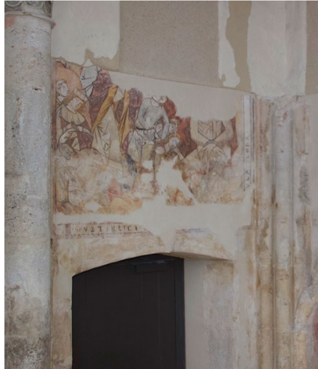
Abb. 12: Gotik und spätere Veränderungen wurden durch Naturputzoberflächen in unterschiedlichen Korngrößen und Kalkfassungen differenziert dargestellt
