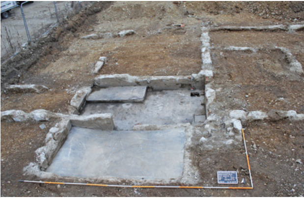
Abb. 1 Algersdorf, Gries, Wetzelsdorf (Mnr. 63107.19.01). Die zwei Duschräume der Baracke Obj. 19 mit dem Betonboden SE 72 (Ansicht gegen Norden).
