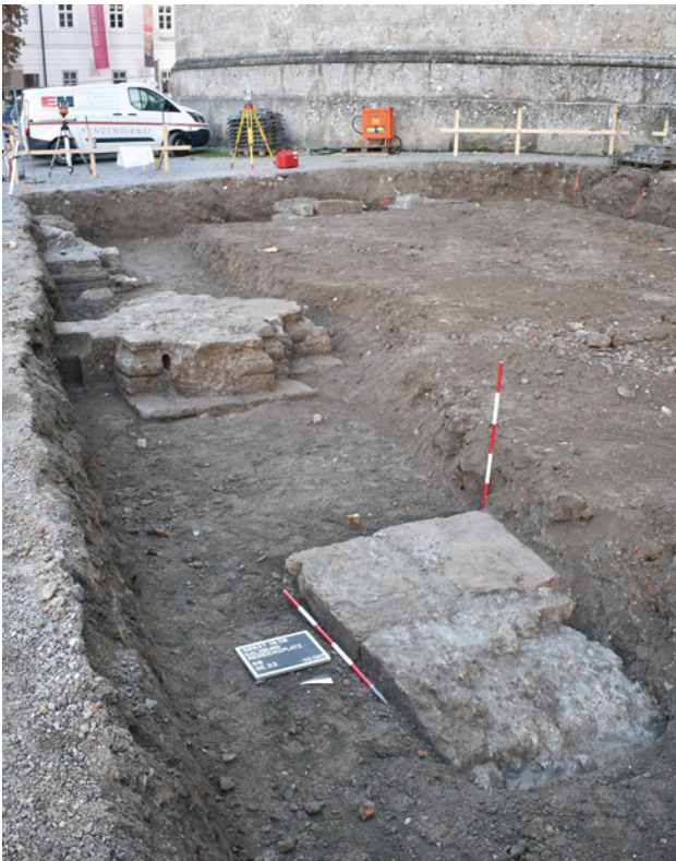
Abb. 6 Salzburg (Mnr. 56537.19.02). Residenzplatz, Kernzone. Baureste des romanischen Doms.
