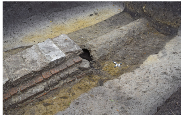
Abb. 14 Petronell (Mnr. 05109.19.12). Originales Kanalgewölbe der römischen Wasserleitung (links) und neuzeitliche Reparatur (rechts).
