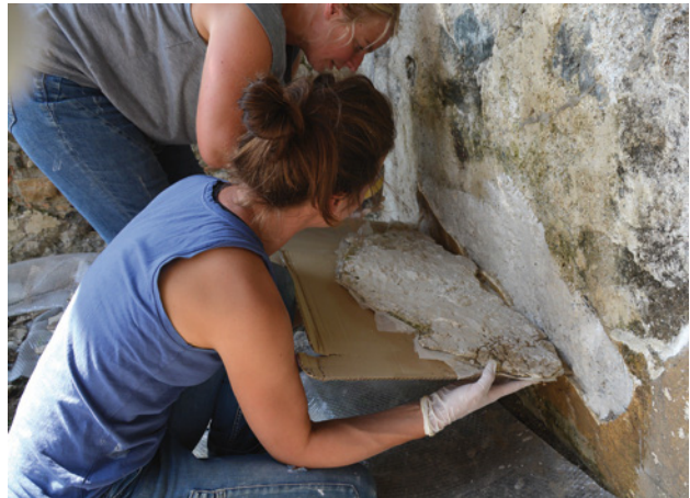
Abb. 23 Magdalensberg (Ktn.). Notsicherungsarbeiten an Wandverputzen im Archäologischen Park Magdalensberg.
