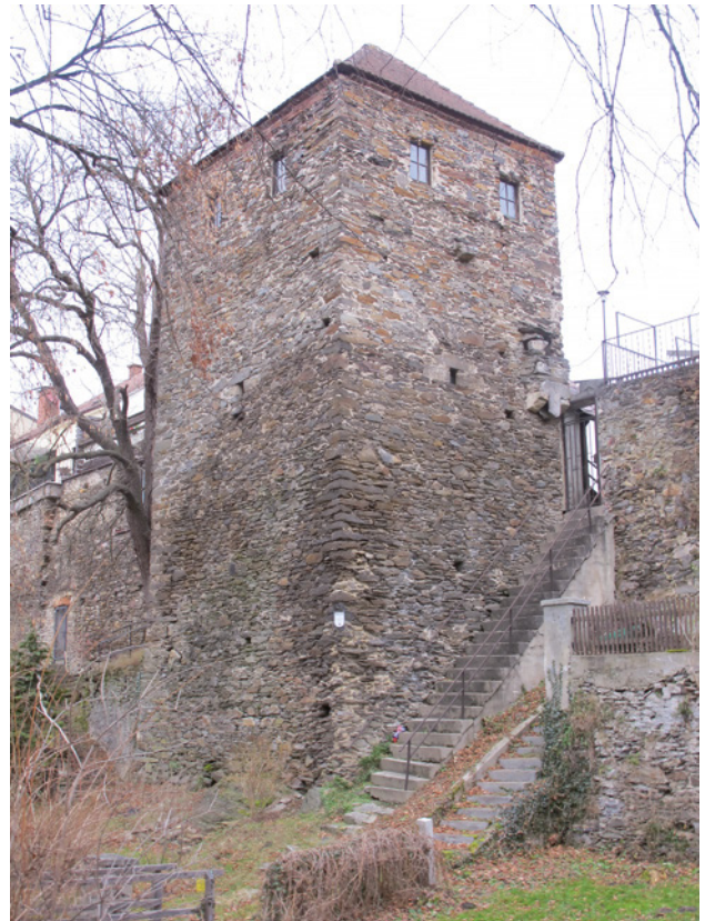
Abb. 40 Zwettl, Stadtbefestigung. Hofbauerturm (Ansicht von Süden).
