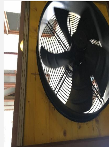
Axialventilatoren, 2./Geschoss (10.000m 3 /h)
